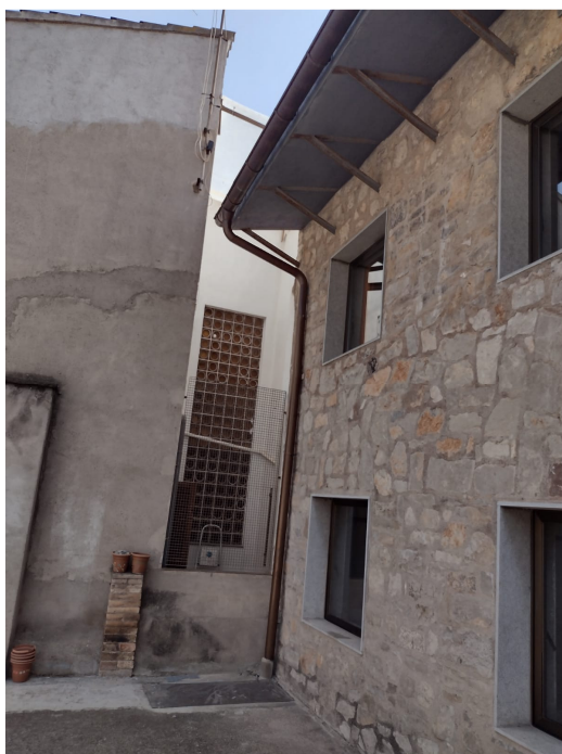
Zona a col·locar nova unitat exterior
