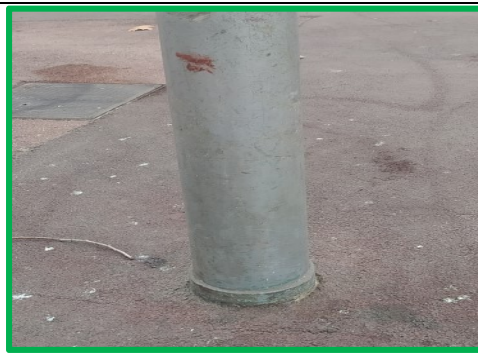
Estat 8: Columna recte, sense entollament, sense orins, entrega del paviment correcta. Encastament sense signes de corrossió ni pèrdua de material. No hi ha espai lliure entre el fust i la base de l'encastament.
