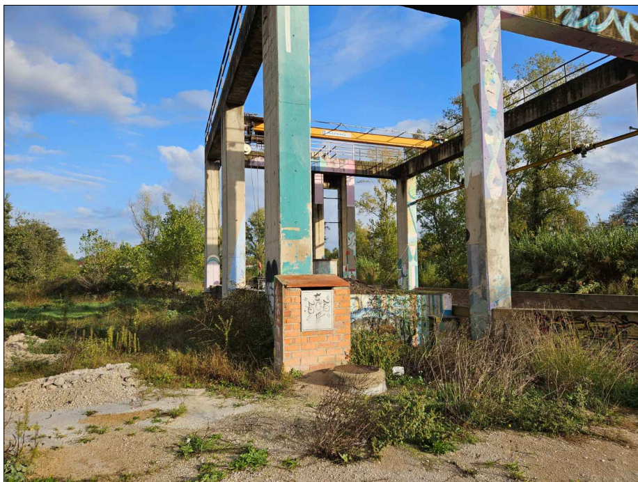
4. ESTRUCTURA DE DESBAST. SERVEIS D'AIGÜA POTABLE A PRIMER PLA
