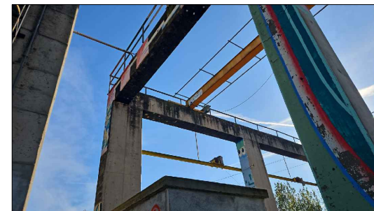
PART FAÇANA EST I COBERTA
