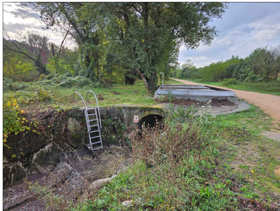
2. VISTA D'ARQUETA DE SOBREEIXIDOR DESDE AIGÜES AMUNT
