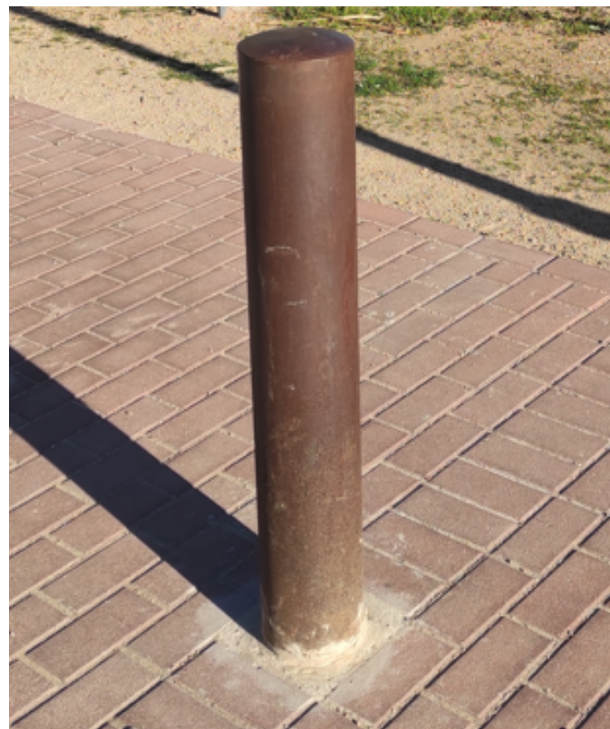
PILONA D'ACER CORTEN DE DIÀMETRE 20 CM I 1 METRE D'ALÇADA
