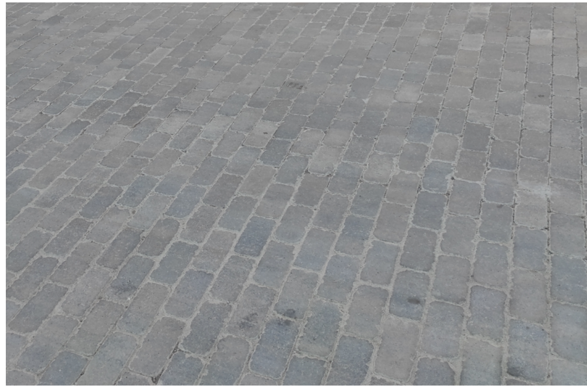
PAVIMENT DE LLAMBORDA TIPUS TEGULA DE BREINCO O SIMILAR COLOR ARENA DE 24X16X8 CM
