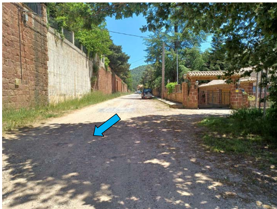
19 Vista general del tram urbà no pavimentat de Prades, objecte actuació pel pas de la canonada de connexió de la nova cambra de cloració a dipòsits de distribució (dipòsit de Forquetes)
