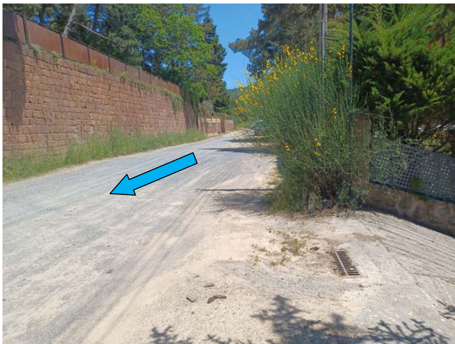
18 Vista general del tram urbà no pavimentat de Prades, objecte actuació pel pas de la canonada de connexió de la nova cambra de cloració a dipòsits de distribució (dipòsit de Forquetes)
