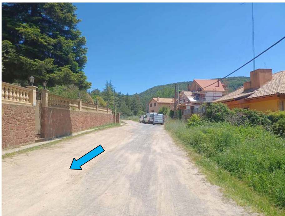
17 Vista general del tram urbà no pavimentat de Prades, objecte actuació pel pas de la canonada de connexió de la nova cambra de cloració a dipòsits de distribució (dipòsit de Forquetes)
