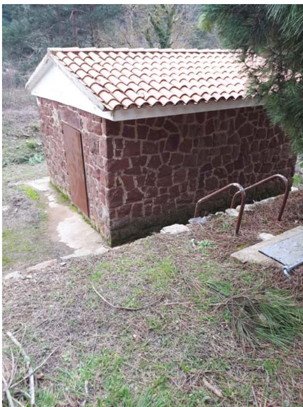
1 Vista general de l'E.T.A.P. de Prades pel tractament de filtració de l'aigua de les captacions superficials acumulades a la bassa de la Font de la Salut
