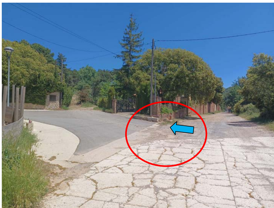
20 Vista general del tram urbà no pavimentat de Prades, punt final objecte actuació pel pas de la canonada de connexió de la nova cambra de cloració a dipòsits de distribució (dipòsit de Forquetes)
