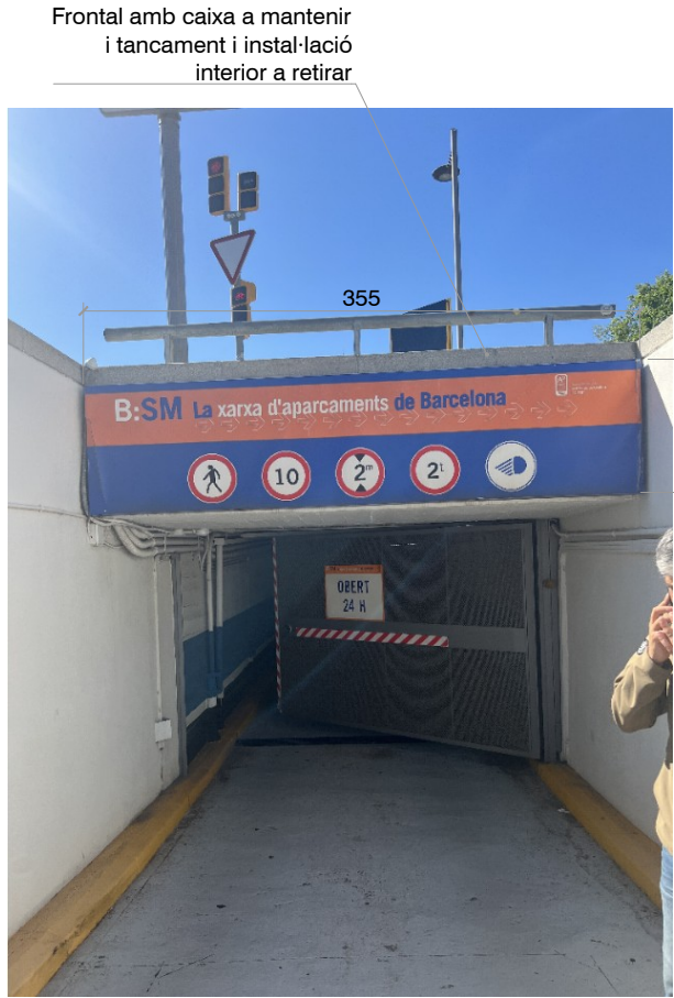
RAMPA ENTRADA AV. DE LA REINA MARIA CRISTINA (R1)
