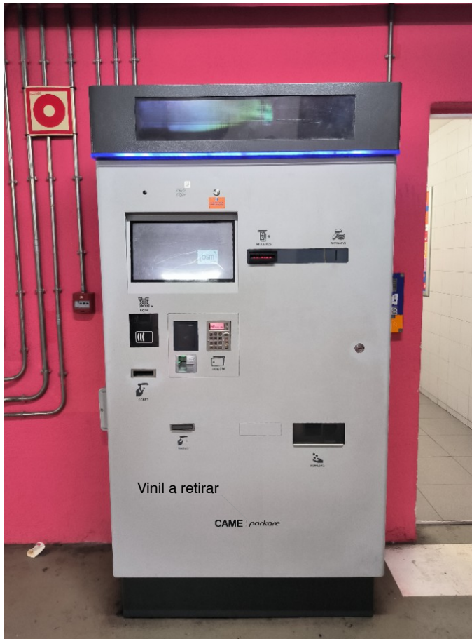
M-CA01 Caixer automàtic 01 - Estat actual
