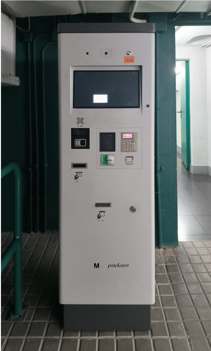
M-CA03 Caixer automàtic 01 - Estat actual
