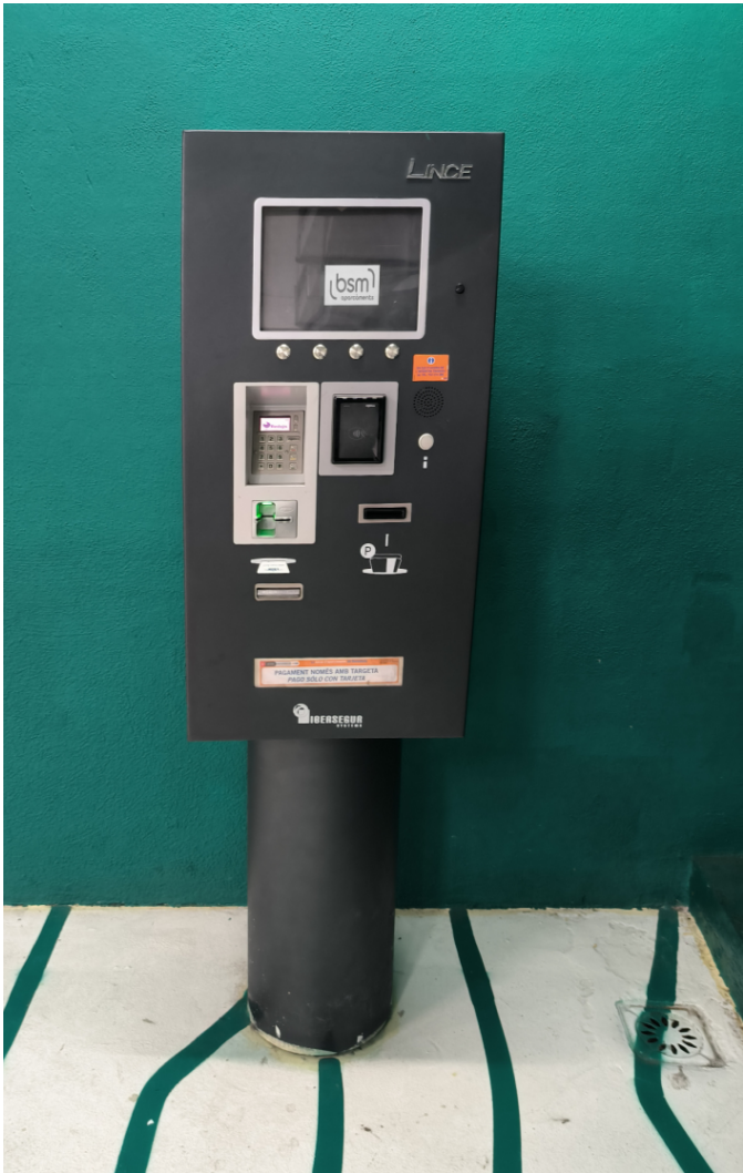
M-CA04 Caixer automàtic 02 - Estat actual
