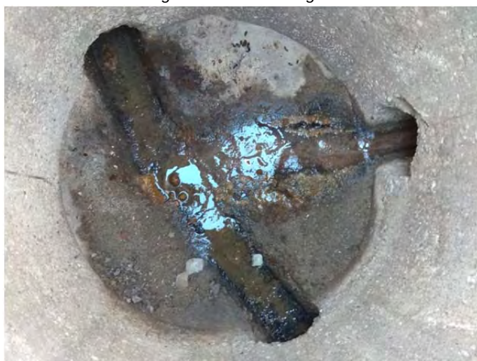
Interior pou registre existent (sud del carrer)
