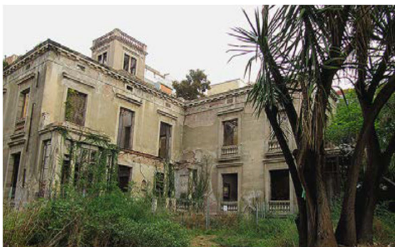
Vista de les façanes de l'edificació existent.
