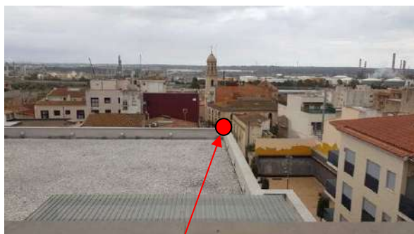
Ubicació masteler cantonada carrer Major
