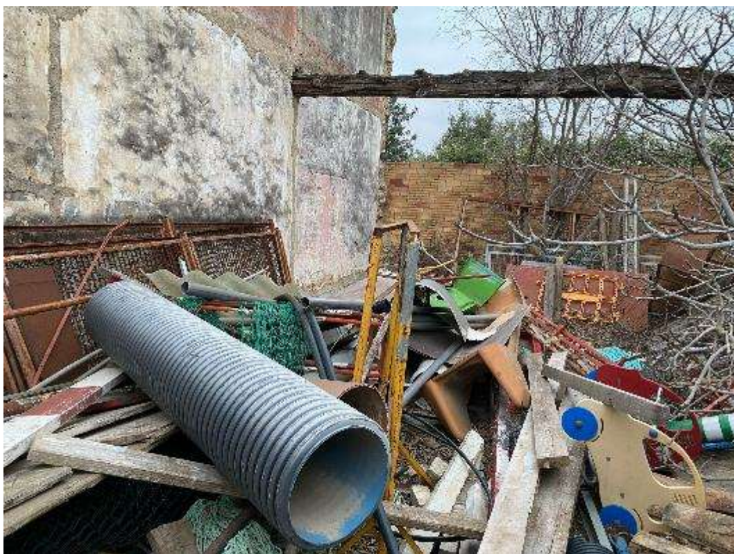
Estat actual interior del solar
