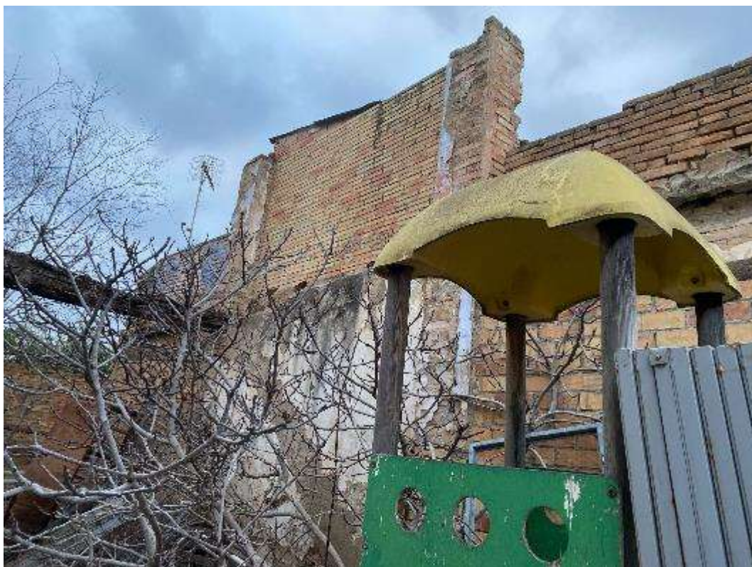
Estat actual interior del solar
