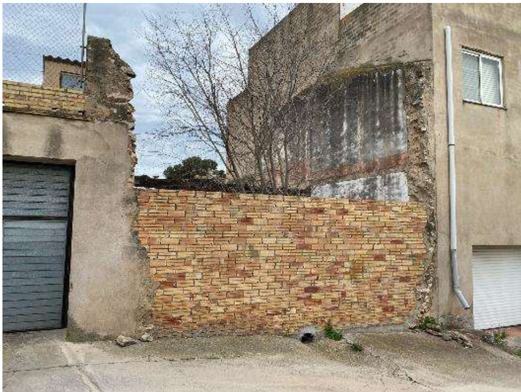
Façana existent, carrer Àvila
