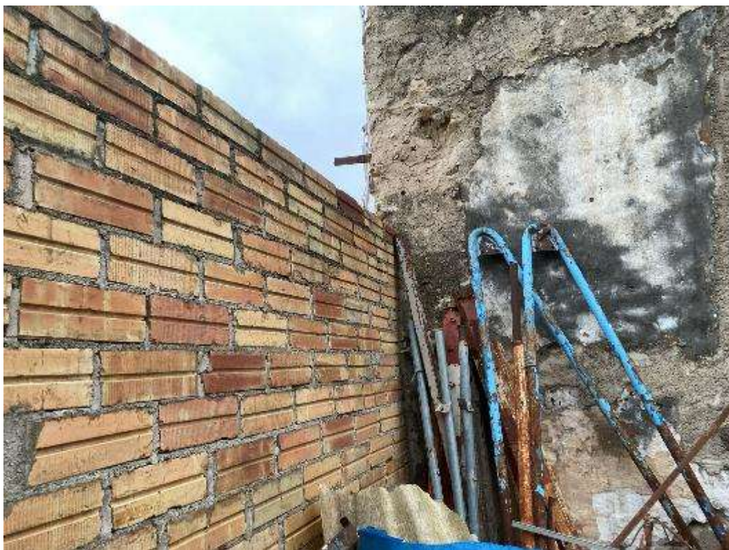
Estat actual interior del solar
