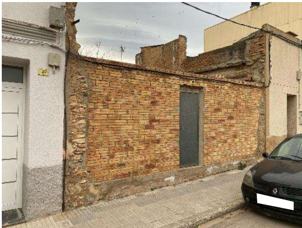
Façana existent Av. Don Álvaro 39
