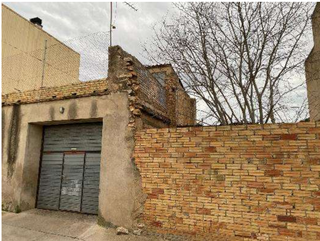
Façana existent, carrer Àvila, mitgera esquerra (dreta Av. Don Álvaro)
