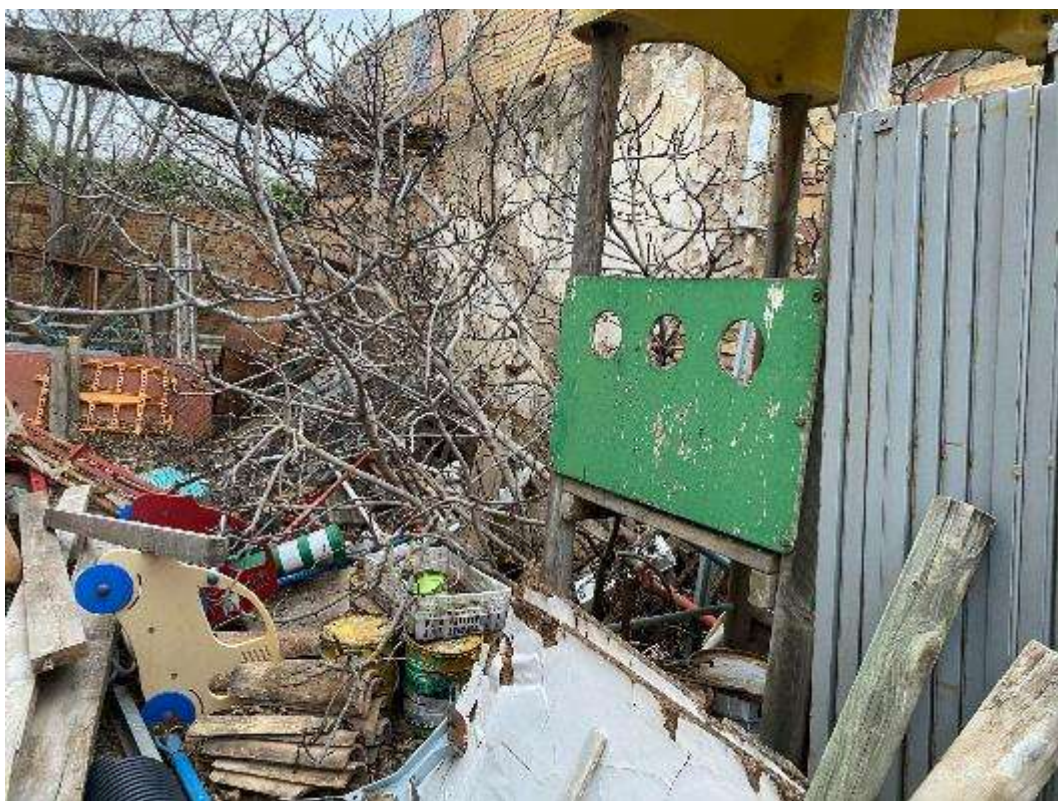
Estat actual interior del solar
