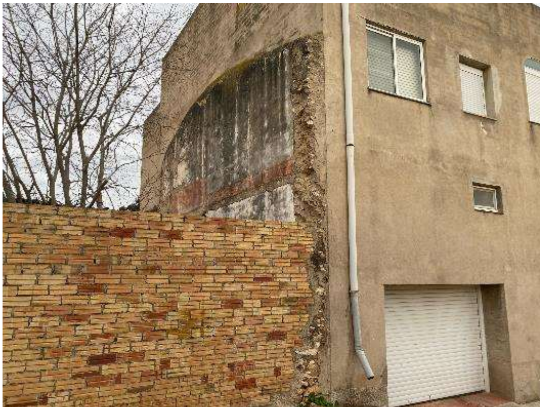
Façana existent, carrer Àvila, mitgera dreta (esquerra Av. Don Álvaro)
