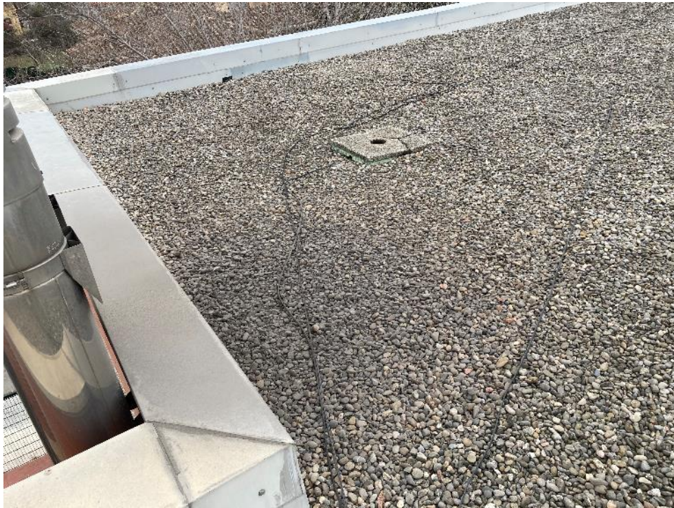
Fotografia 27: Detall de la canalització de desaiqua de la coberta superior
