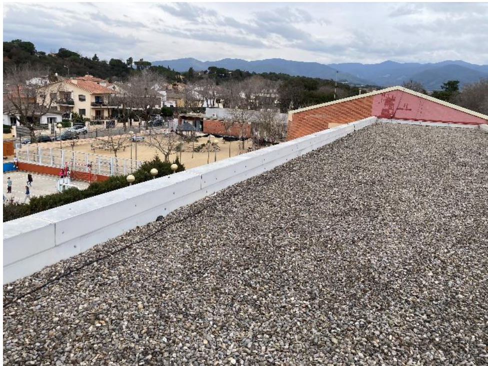
Fotografia 24: Estat actual de la coberta a actuar
