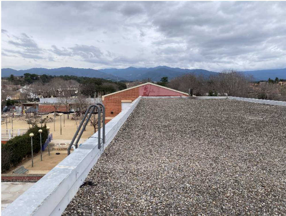
Fotografia 28: Vista panoràmica de la coberta superior a instal·lar les plaques FV
