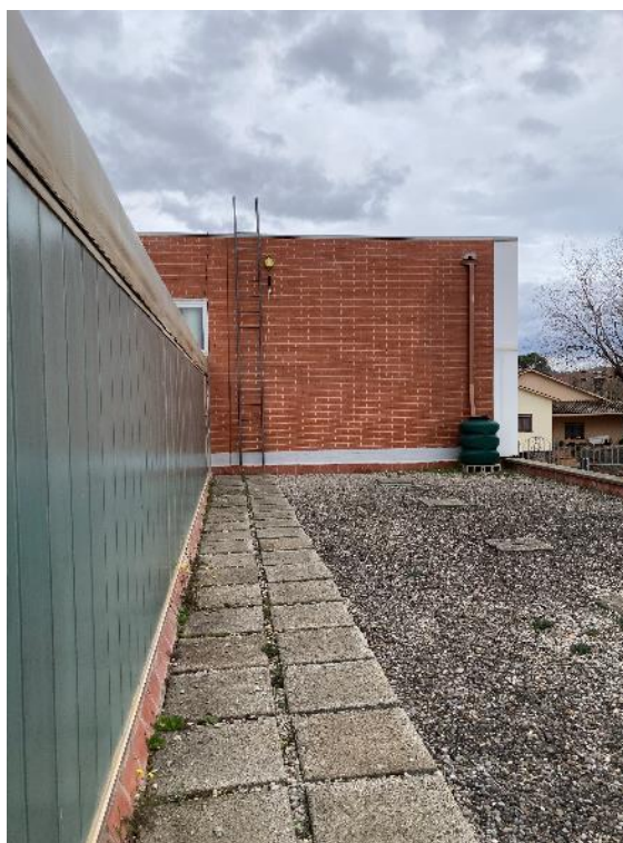
Fotografia 20: Estat actual de la coberta inferior a la zona d'actuar
