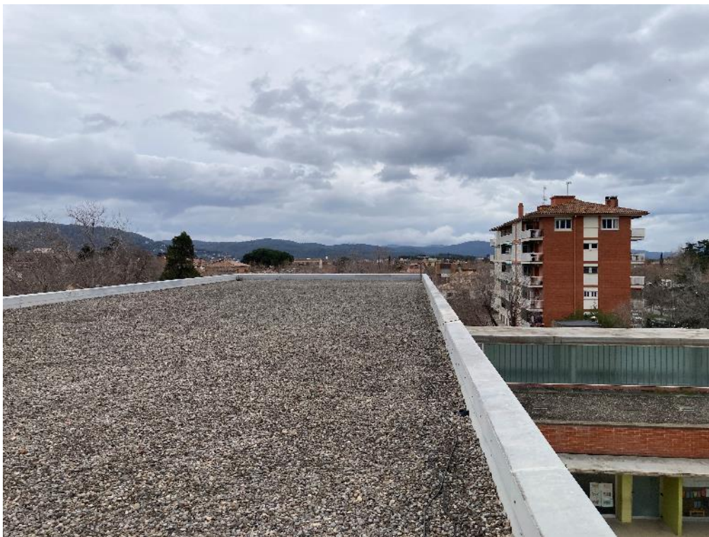
Fotografia 26: Estat actual de la coberta a actuar amb vista panoràmica de Nord - Sud
