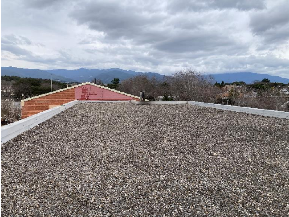
Fotografia 25: Estat actual de la coberta a actuar amb vista panoràmica de Sud - Nord
