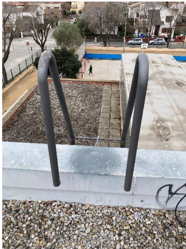
Fotografia 22: Detall de l'escala per poder accedir a la coberta superior
