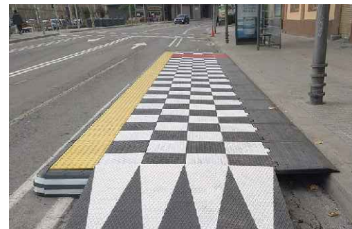
PLATAFORMA D'AUTOBÚS MODULAR, AMB CARRIL BICI INTEGRAT, FORMADA PER PEÇES ACOBLABLES DE PVC RECICLAT, AMB SUPERFÍCIE ANTILLISCANT - 2 UTS
