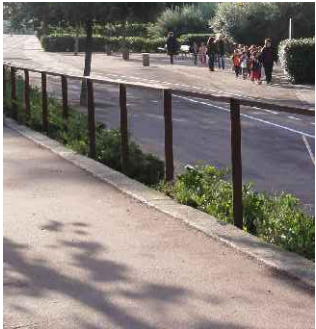
E-12 PASSAMÀ D'ACER GALVANITZAT EN CALENT
