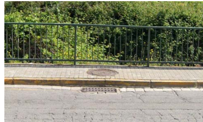
Embornal i pou de la xarxa de clavegueram existent al carrer Joan d'Àustria
