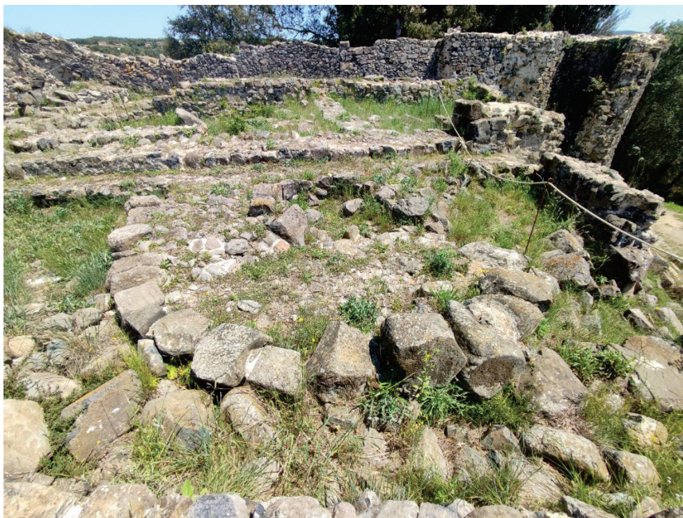
Estructura circular del sector 13, on cal assegurar l'estabilitat del coronament dels carreus i pedres originals
