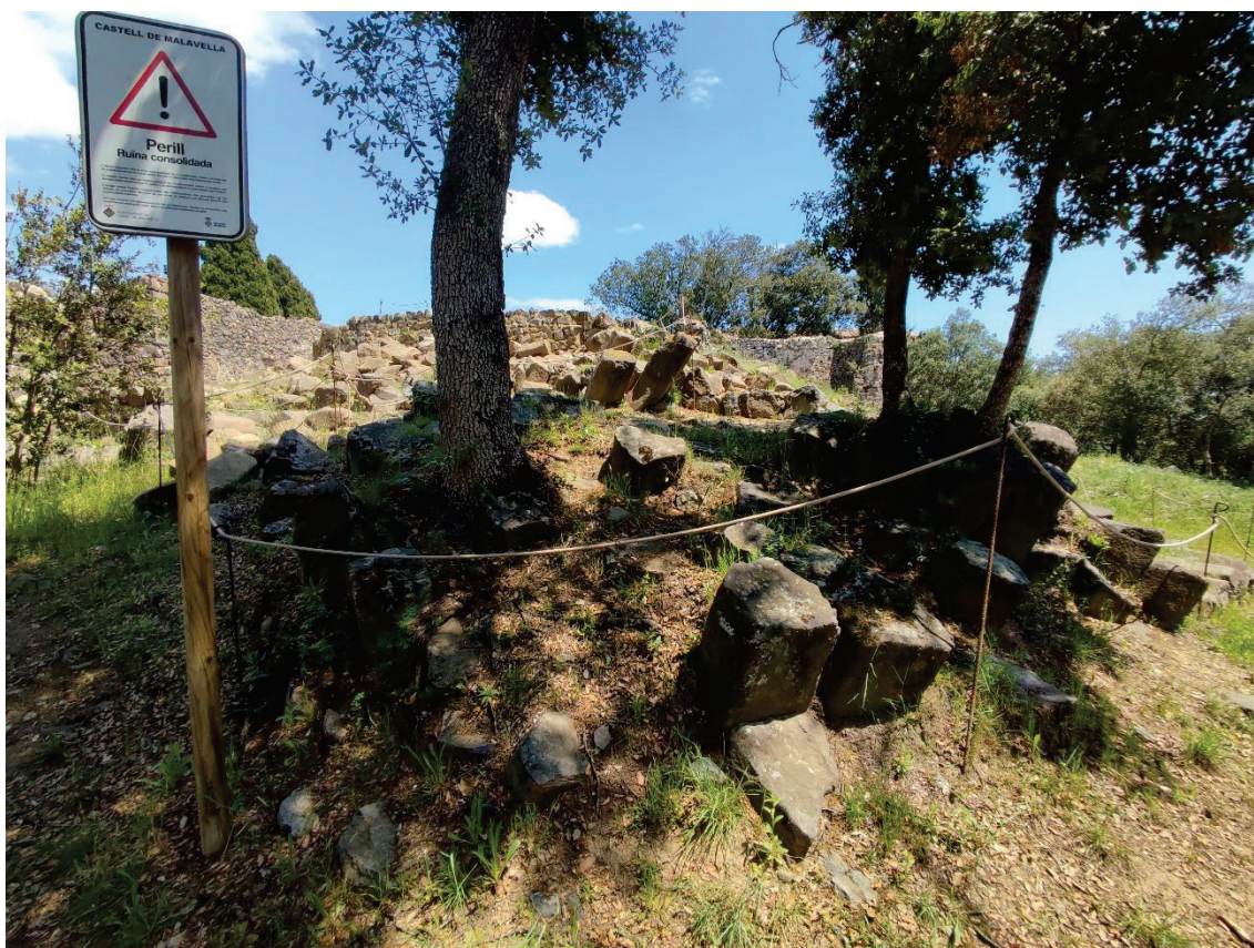
Estat actual de la torre de la cantonada sud-oest, que es proposa consolidar parcialment per tal de facilitar la lectura de l'element i evitar l'esllavissada de terres actual
