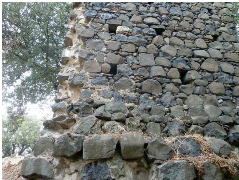
Il·lustració 1: Parament d'una de les torres del castell de Malavella on s'observa tant l'ús de blocs basàltics directament extrets de l'aflorament que serveix de base al castell, units amb morter i reblert, com l'espoli de les cantonades que havien estat construïdes amb blocs regulars.
