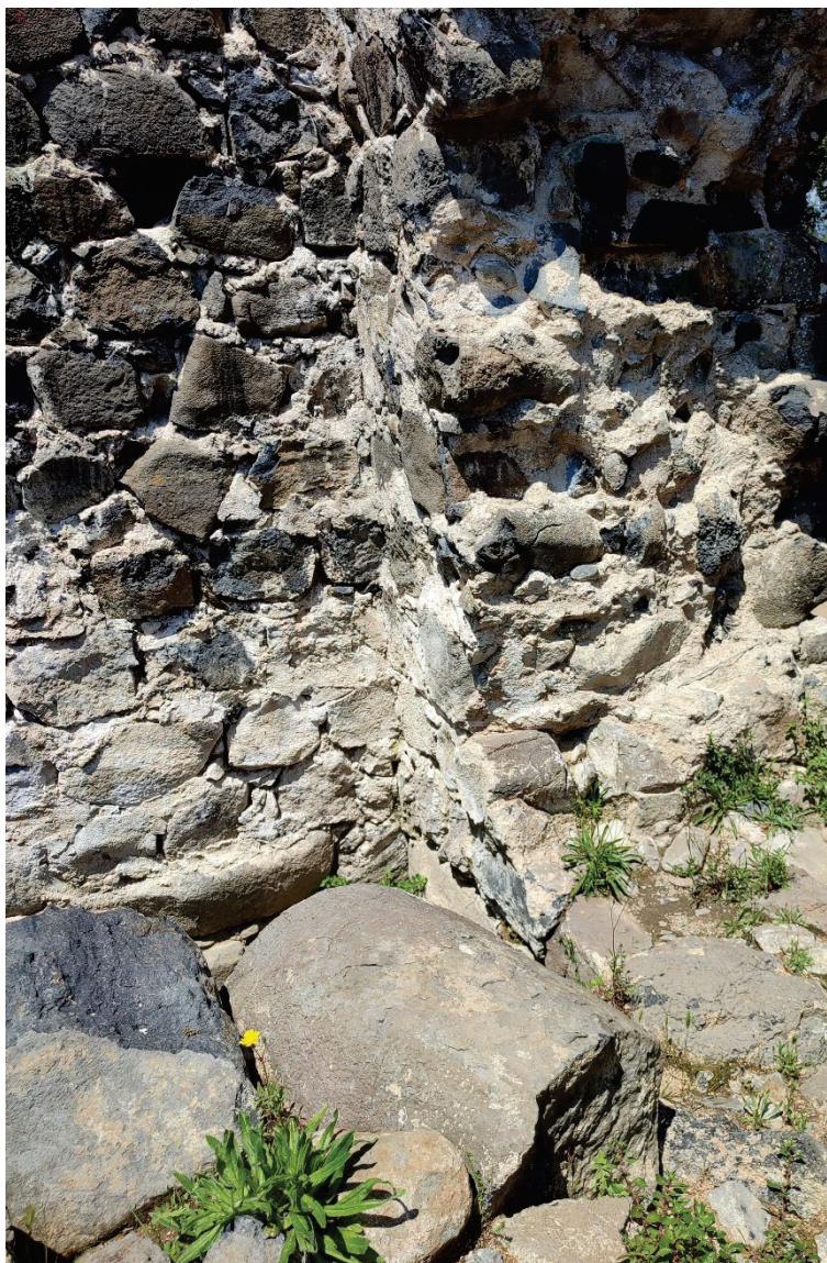
Cantonada de la torre nord-oest a consolidar. S'observa la composició dels morters originals de lligada dle mur de maçoneria
