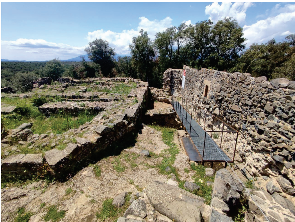
Vista actual des de l'escala d'accés a la torre nord-est
