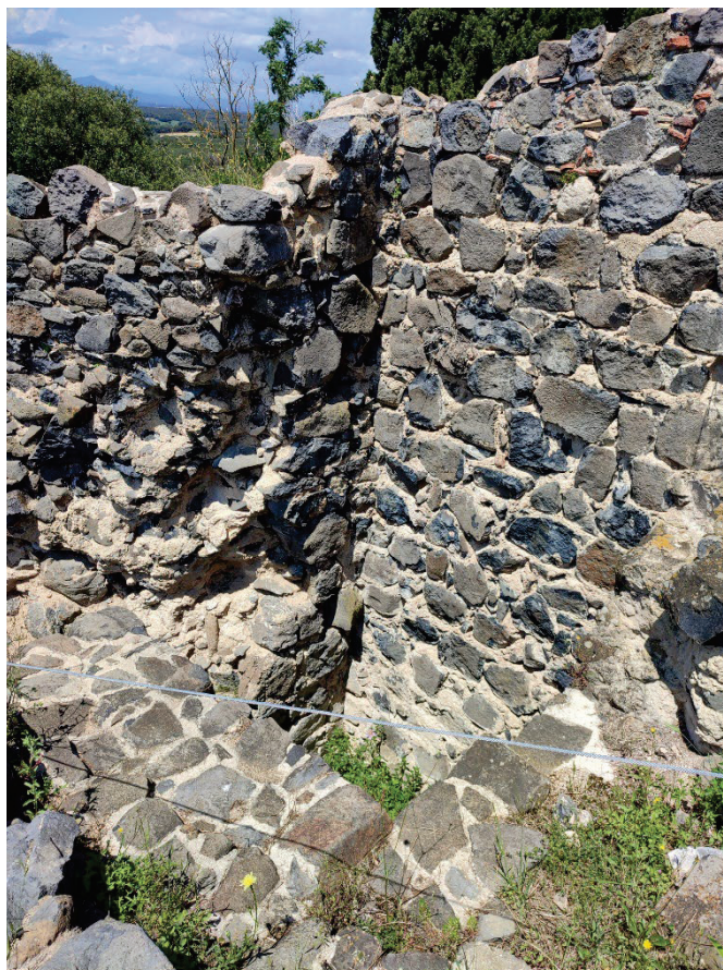
Cantonada de la torre nord-est a consolidar
