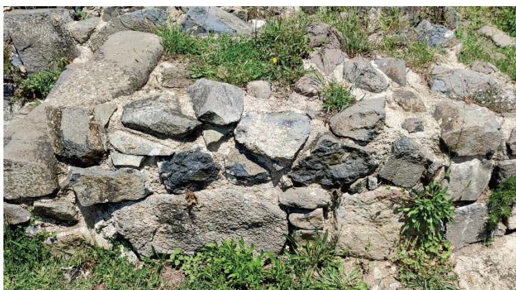
Detall del morter dels murs i estructures de maçoneria
