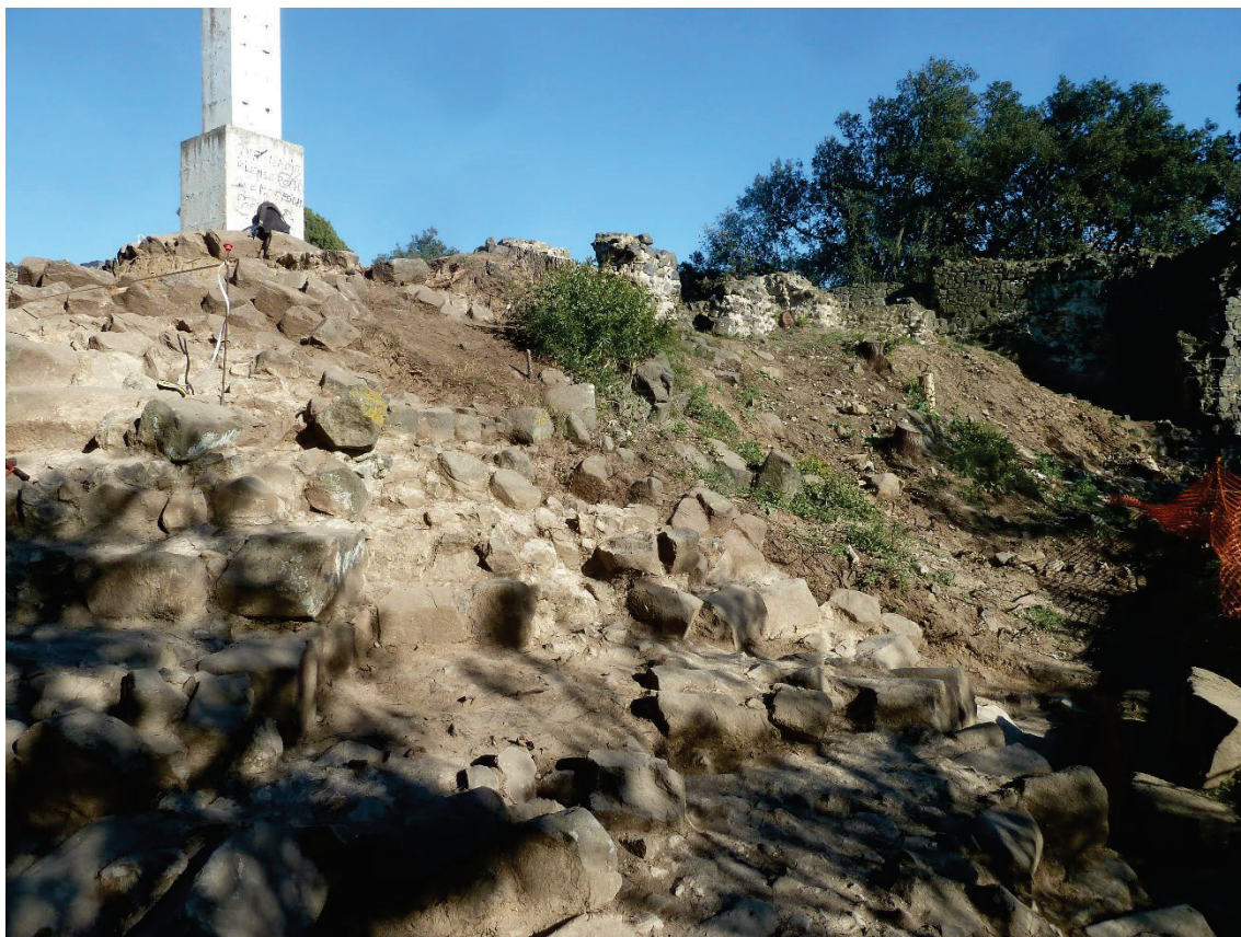
Estat previ de l'interior del recinte, on encara es pot observar el punt geodèsic
