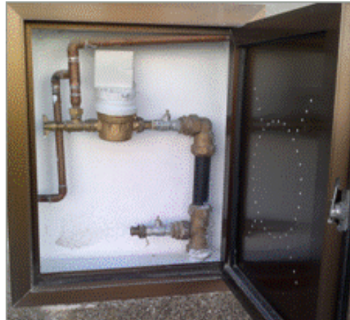
Exemples d'instal·lacions de comptador amb mòdul de teletrelectura incorporat
