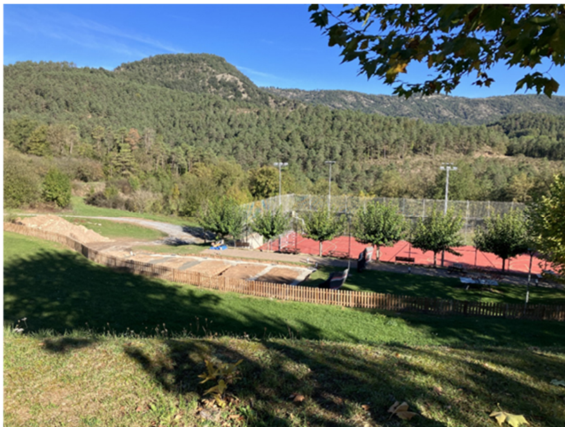
Fonaments de l'edifici en construcció
