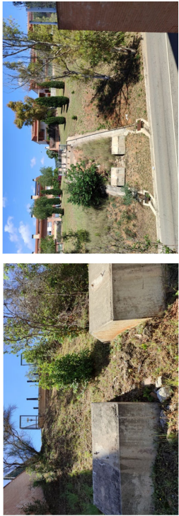
Fotografies 1 i 2. Estreps i piles de la passera antiga de fusta
