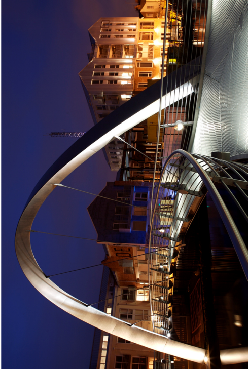
Figura 4. Exemple d'il·luminació de l'estructura superior per l'atrancat de la passera de ERCO
