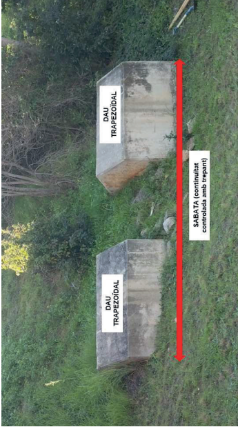
Fotografia 5: Vista general de l'estructura existent de la sabata de les piles del costat Sud
