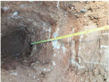
Fotografia 3: Caia C-02 acabada.
