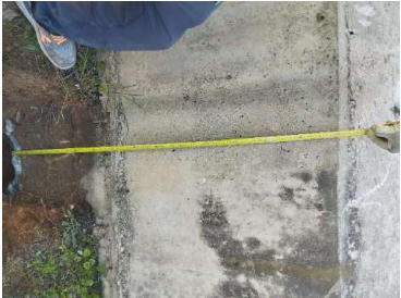
Fotografia 3: Cata C-01 acabada.
