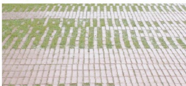
Identificació dels paviments, segons documentació gràfica, i exemples executats de paviments amb rajol ceràmic alterns amb vegetació i disposició variada
