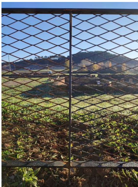
Tanca delimitadora del jaciment de Vilauba (Camós, Pla de l'Estany), de tipologia similar a la plantejada al projecte. En aquest cas però, el material és acer corten i la disposició del deployé és horitzontal.
