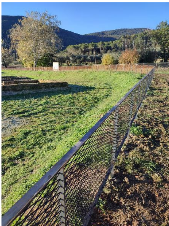
Tanca delimitadora del jaciment de Vilauba (Camós, Pla de l'Estany), de tipologia similar a la plantejada al projecte. En aquest cas però, el material és acer corten i la disposició del deployé és horitzontal.
