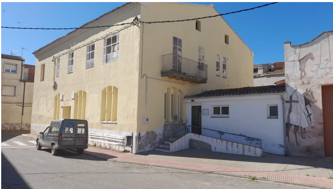
Façana nord en la que s'observa l'accés a la sala de vetlles
