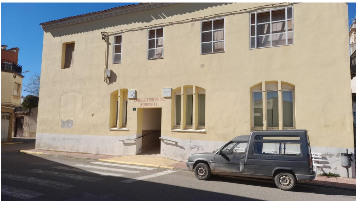
Façana est (accés al dispensari)
