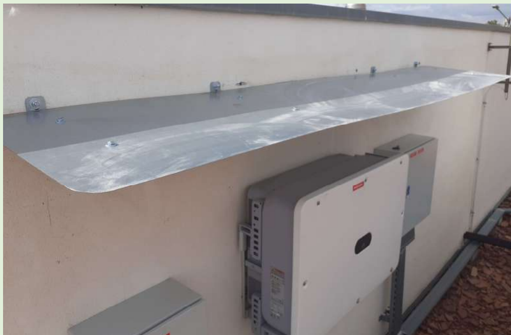
Petita coberta per la protecció de l'inversor i els quadres de protecció.
