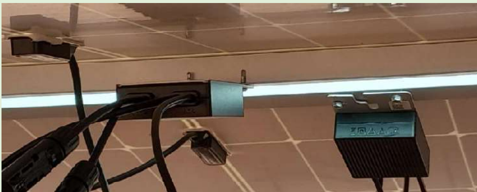
Marc foradat quan el optimitzador té el forat indicat per ser instal·lats en els forats del panell. No confondre els forats del terra amb els forats habilitats per altres utilitzacions com per exemple, acollaments per sota.
