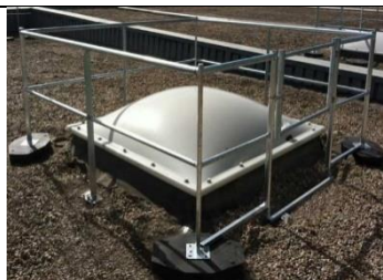
Figura 3. Ejemplo protección claraboyas con barandilla
