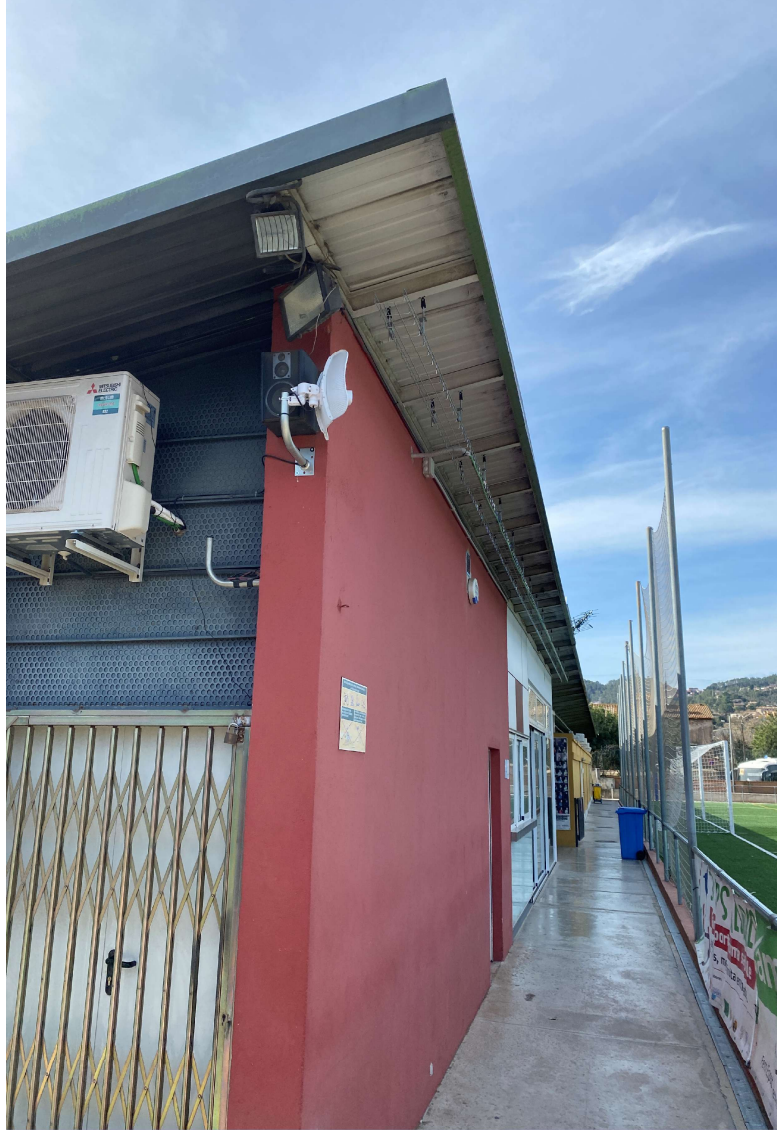
Imatge 3. Coberta de l'edifici des de l'interior del recinte
