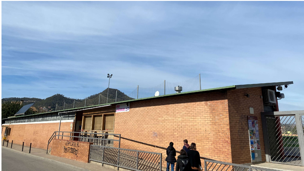
Imatge 1. Edifici del Camp de Futbol Eusebi Güell
