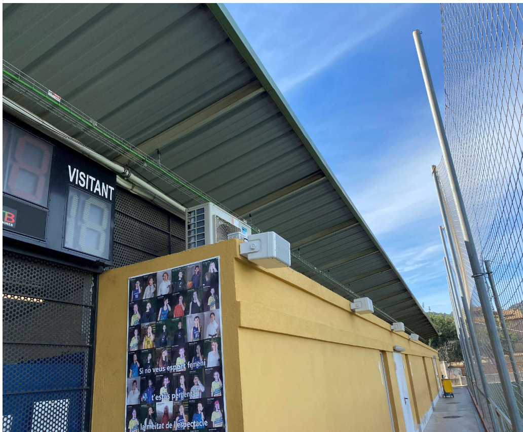
Imatge 2. Coberta de l'edifici des de l'interior del recinte
