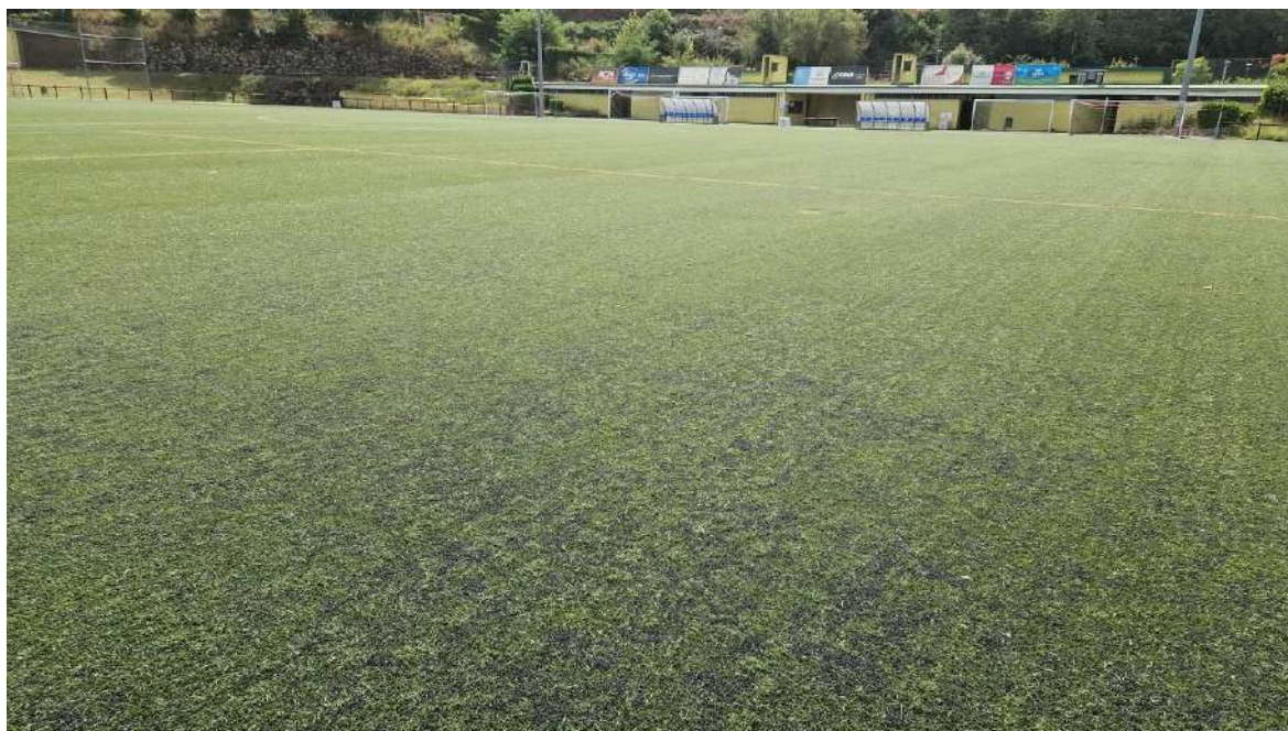
Imatge actual d'un dels còrners on resulta evident el predomini del color negre del cautxú envers el color verd dels filaments de gespa artificial, adquirint en el seu conjunt una tonalitat fosca que no es correspon amb el normal color verd de la gespa que caldria esperar.
