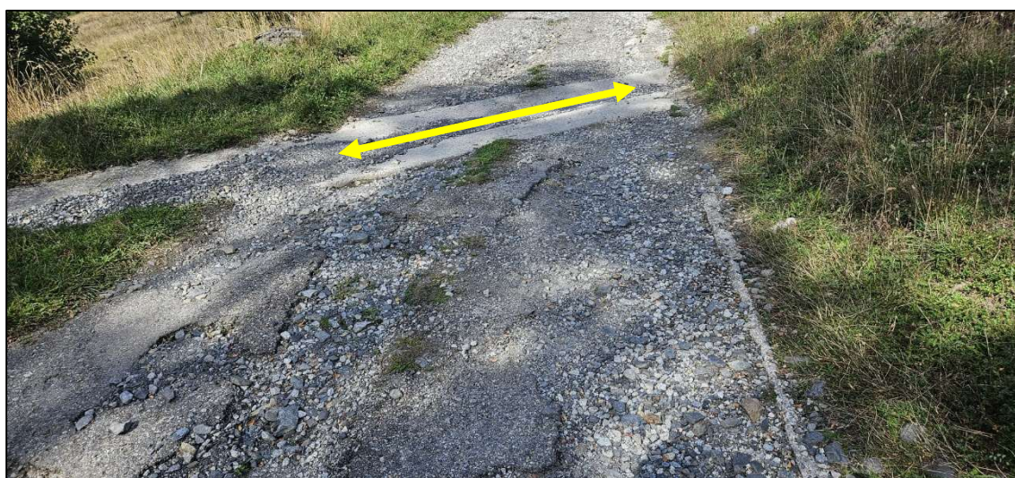
Il·lustració 6: Cuneta transversal obstruïda
