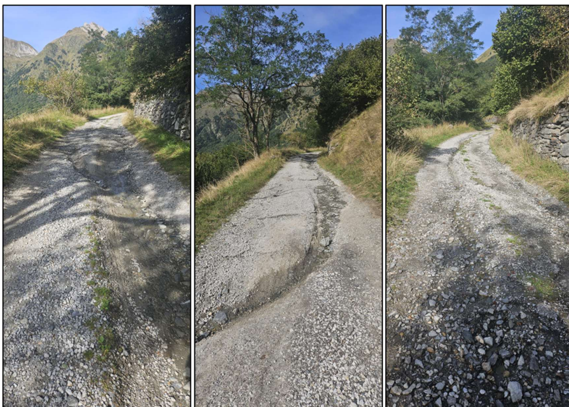
Il·lustració 4: Tramo con superficie con baches, erosión longitudinal, pérdida de material granular y cárcavas que afectan a la transitabilidad.
