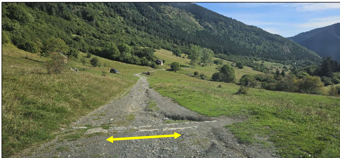
Il·lustració 7: Cuneta transversal obstruida
