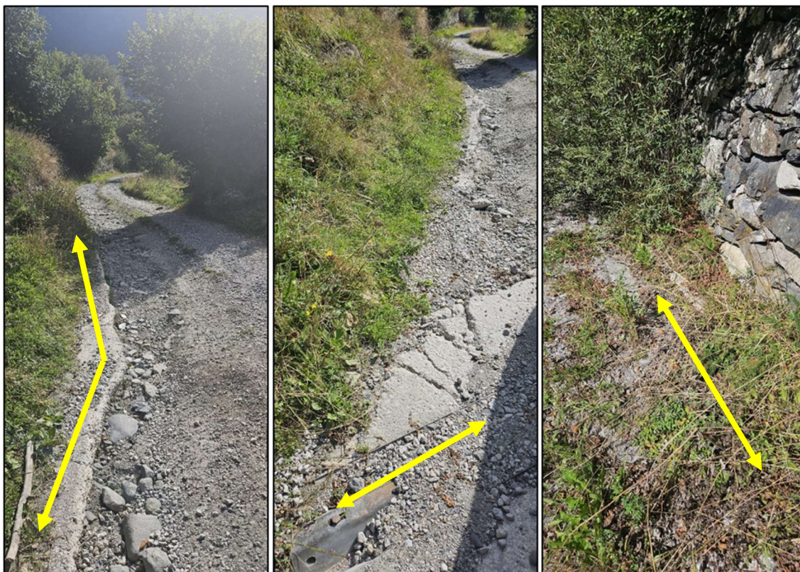
Il·lustració 5: Cuneta lateral obstruïda per material suelt i vegetació, amb pèrdua de secció hidràulica.
