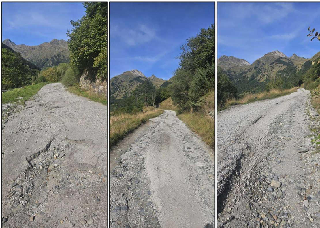
Il·lustració 3: Tramo con superficie con baches, erosión longitudinal, pérdida de material granular y cárcavas que afectan a la transitabilidad.
