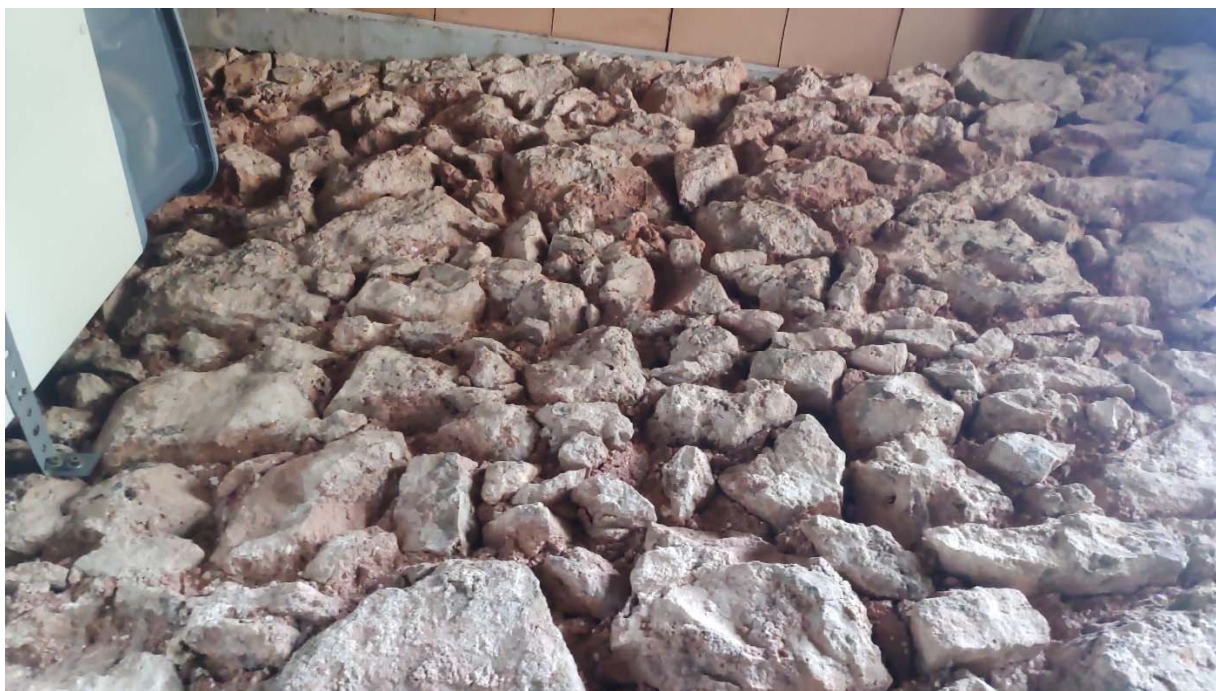
Vista interior de l'aparell de pedra en l'escala. Degradació del morter de calç.
