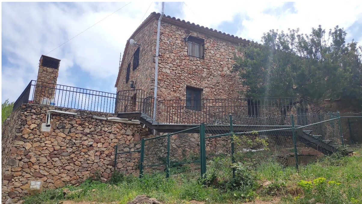
Vista general de l'exterior de l'edifici.
