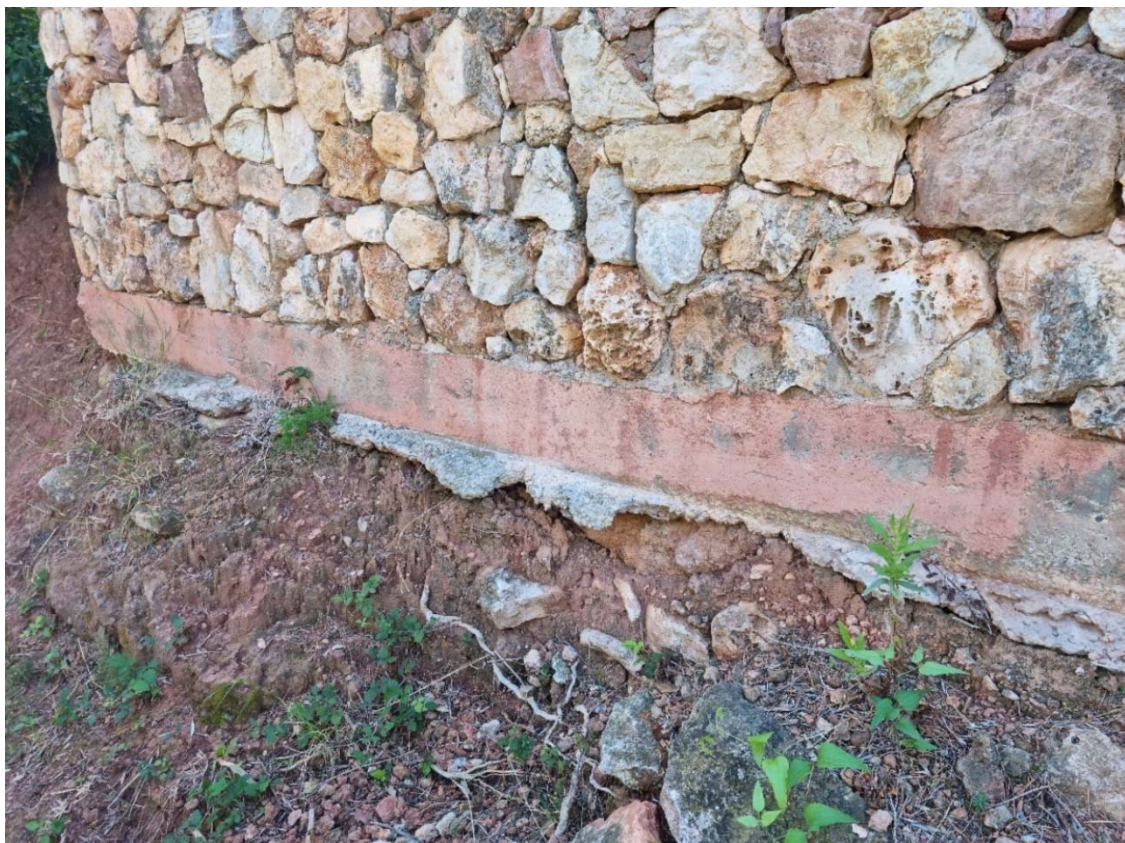
Fonamentació - Estat actual de la fonamentació amb fotografies des de l'exterior.
