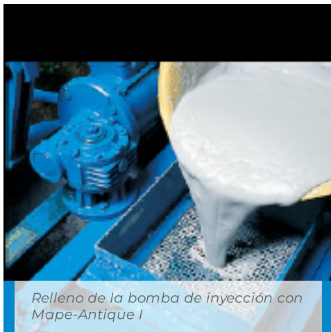
Amasado de mortero de inyección Mape-Antique I
