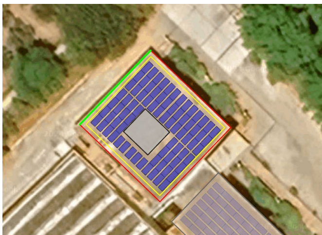
Imatge 9. Camp de captació – Zona 1
