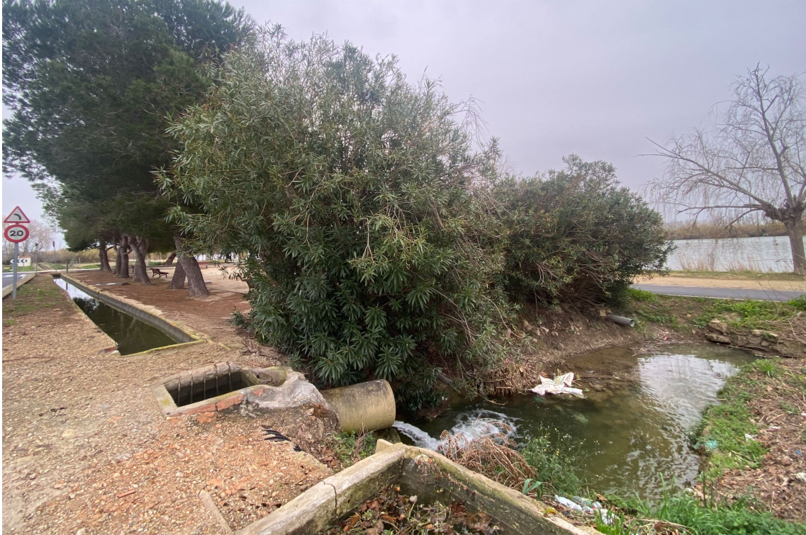
Fig. 2 - Fotografia de la zona d'evacuació d'aigües pluvials a l'oest de l'àmbit
