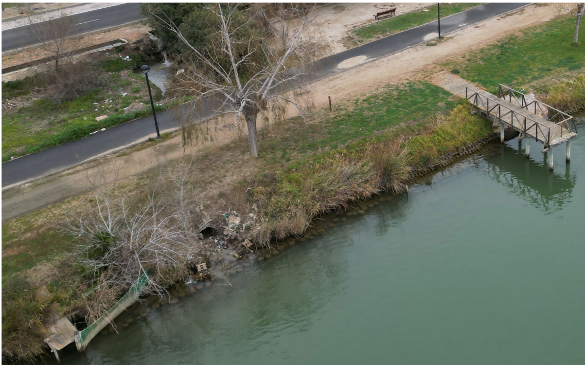
Fig. 3 - Fotografia de la zona de l'abocament d'aigües pluvials
