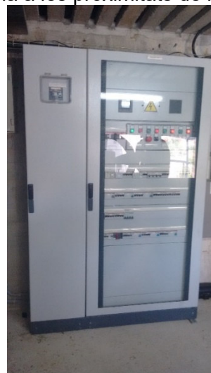
Foto 1 : Foto subquadre que alimenta les comportes existents
