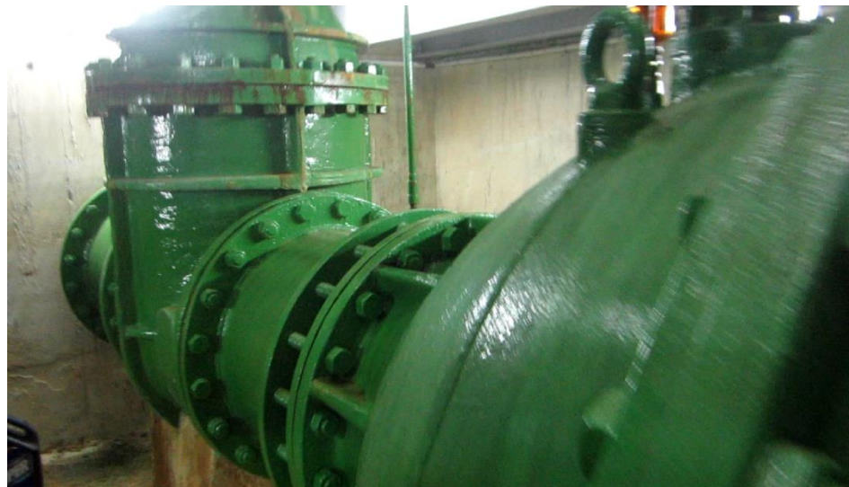
Foto 9. Vista de la cambra de vàlvules del desguàs de mig fons. Nivell inferior.
