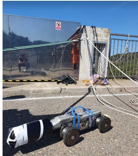
Fotografia 1 Càmera per a la inspecció dels desguassos de mig fons (DMF), des del parament aigües avall
