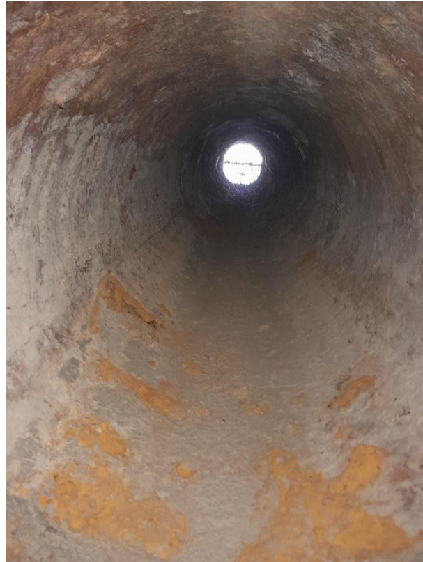
Fotografia 5 Estat actual del blindatge de la conducció aigües amunt de la cambra de vàlvules de DMF. Al fons
