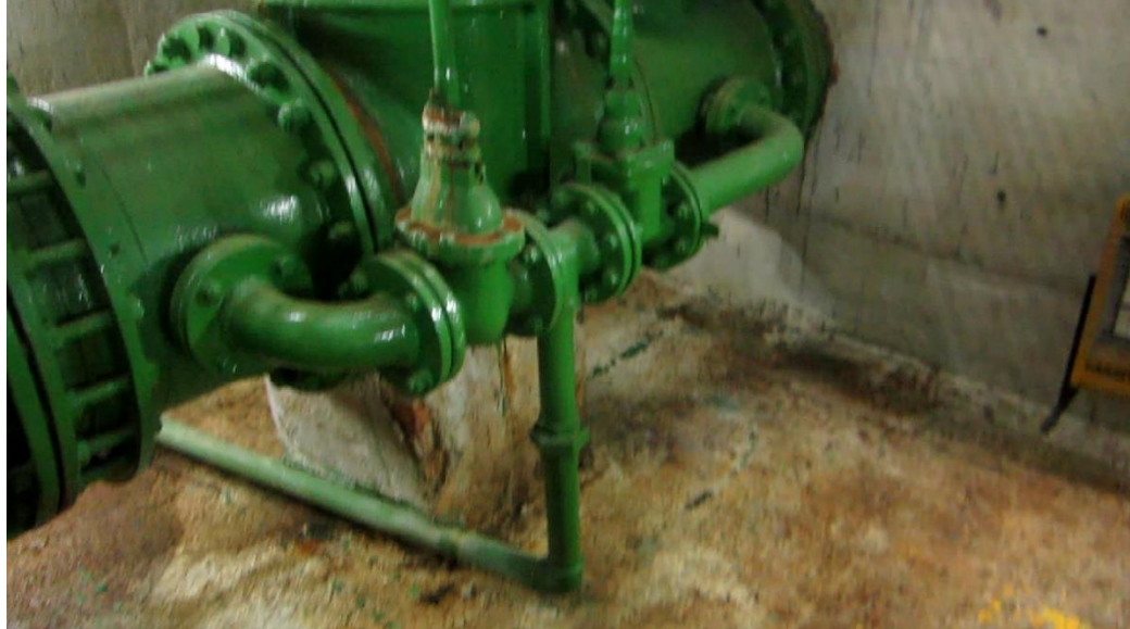
Foto 5. Presa per a servei d'instal·lacions de la presa.
