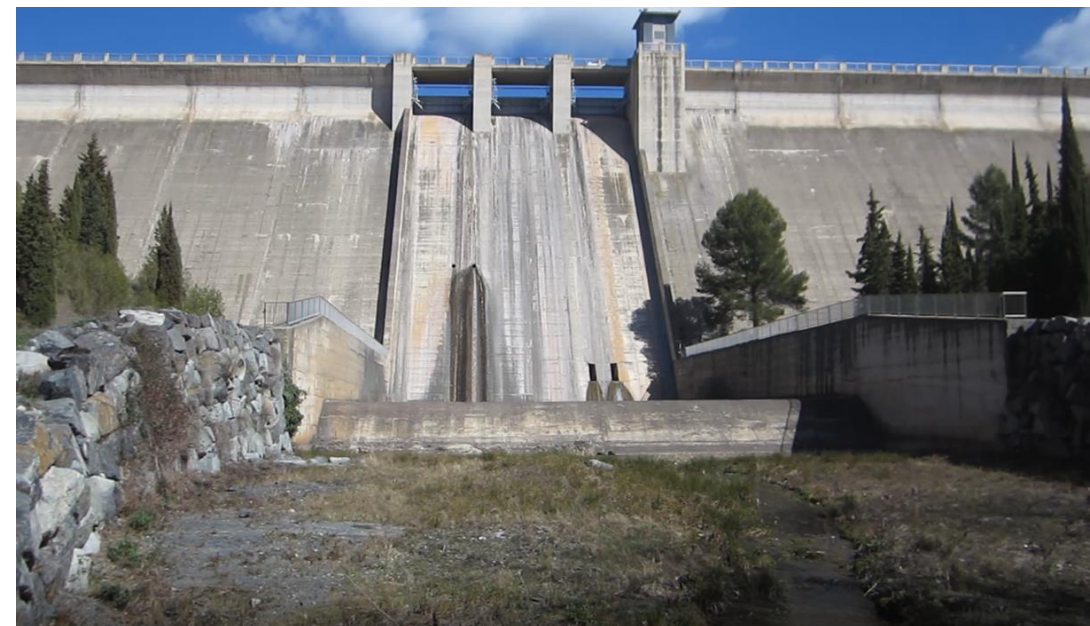
Fotos 1 i 2. Vista de la presa de Siurana.
