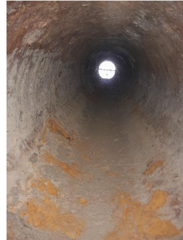
Fotografia 19 Estat actual del blindatge de la conducció aigües amunt de la cambra de vàlvules de DMF. Al fons s'observa la reixa de l'embocadura.
