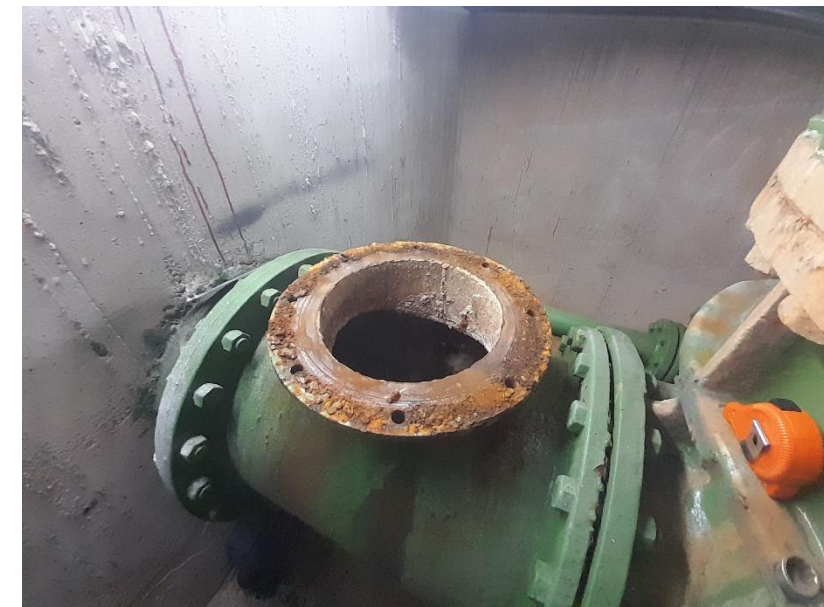
Fotografia 4 Registre on es va treure la brida cega per ficar la càmera de .foto i vídeo
