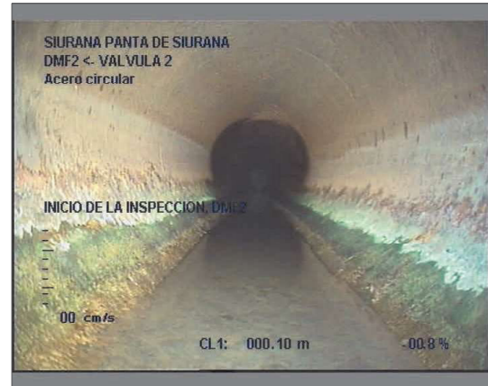
Foto: 2_1_1_13072023_123040_A.JPG 0m, INICIO DE LA INSPECCION, DMF2
