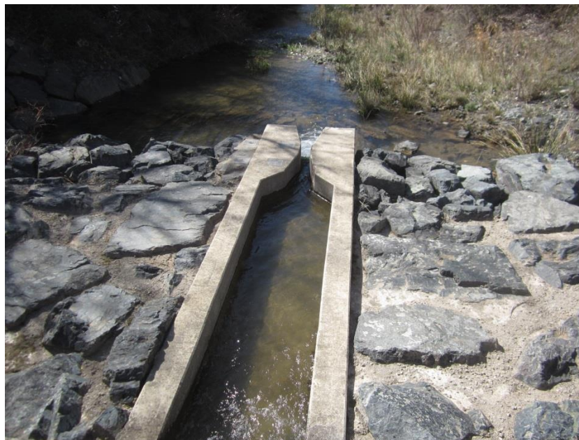
Foto 7. Mesurador Parshall aigües avall del vas esmorteïdor
