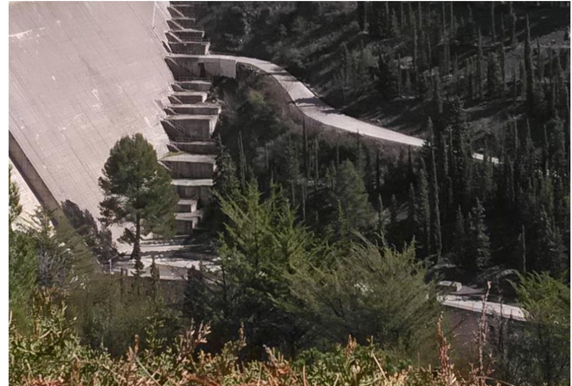
Foto 10. Accessos a cambres de vàlvules de desguassos de fons i intermedi
