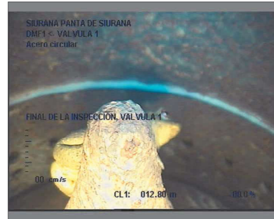
Foto: 1_1_3_13072023_121905_A.JPG 12,8m, FINAL DE LA INSPECCION, VALVULA 1
