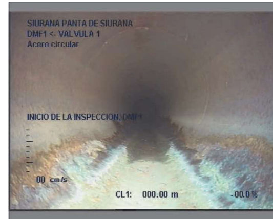
Foto: 1_1_1_13072023_120742_A.JPG 0m, INICIO DE LA INSPECCION, DMF1
