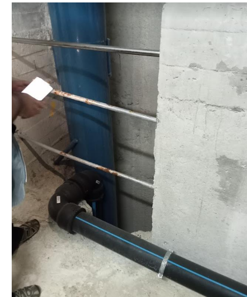
Fotografia 12 Baixada de la canonada provisional d'abastament al Topograpo des de la galeria de presses cap a la galeria intermèdia, des d'on surt a l'exterior de la presa.
