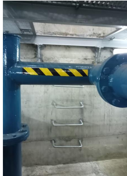
Fotografia 5 Escaleres d'accés a la part inferior de la cambra
