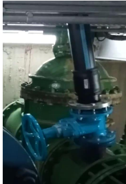
Fotografia 9 Connexió de captació provisional (a eliminar) per a l'abastament al Topograpo, realitzada entre la vàlvula de seguretat i la vàlvula de regulació de la línia DMF de l'esquerra (mirant aigües avall). Vàlvula i tub PEAD DN125.
