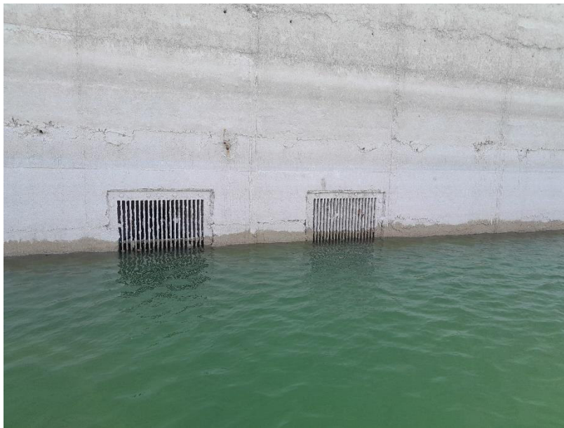
Fotografia 1 Reixes a l'embocadura dels DMF
