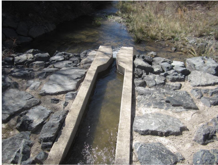
Foto 14. Mesurador Parshall aigües avall del vas esmorteïdor.
