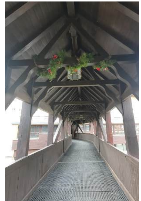
Garlanda sobre la làmpada central del pont
