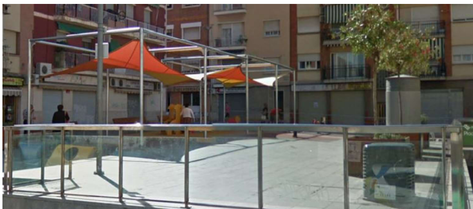
Foto 1. Estructura de protecció solar instal·lada a la Plaça del Carme de Sant Joan Despí a l'any 2015.
