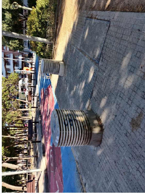
Foto 1. Centre Transformació solerat
