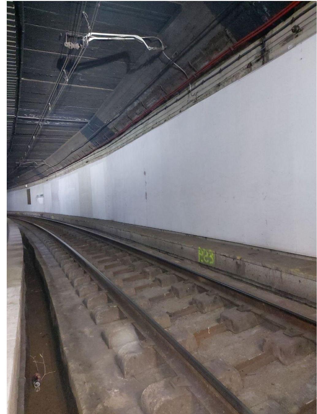
Fotografia 8 - Estació Manresa Viladordis, volta plana amb baix gàlib d'altura
