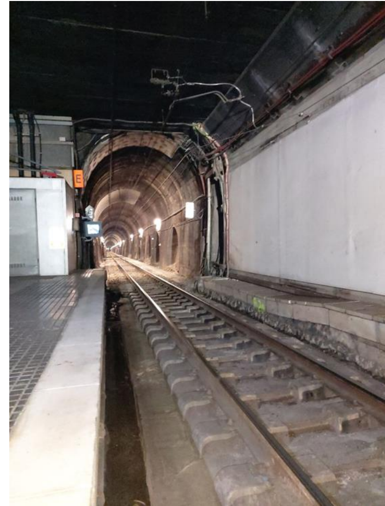
Imatge 5- Estació Manresa-Viladordis, zona amb mínima altura de catenària
