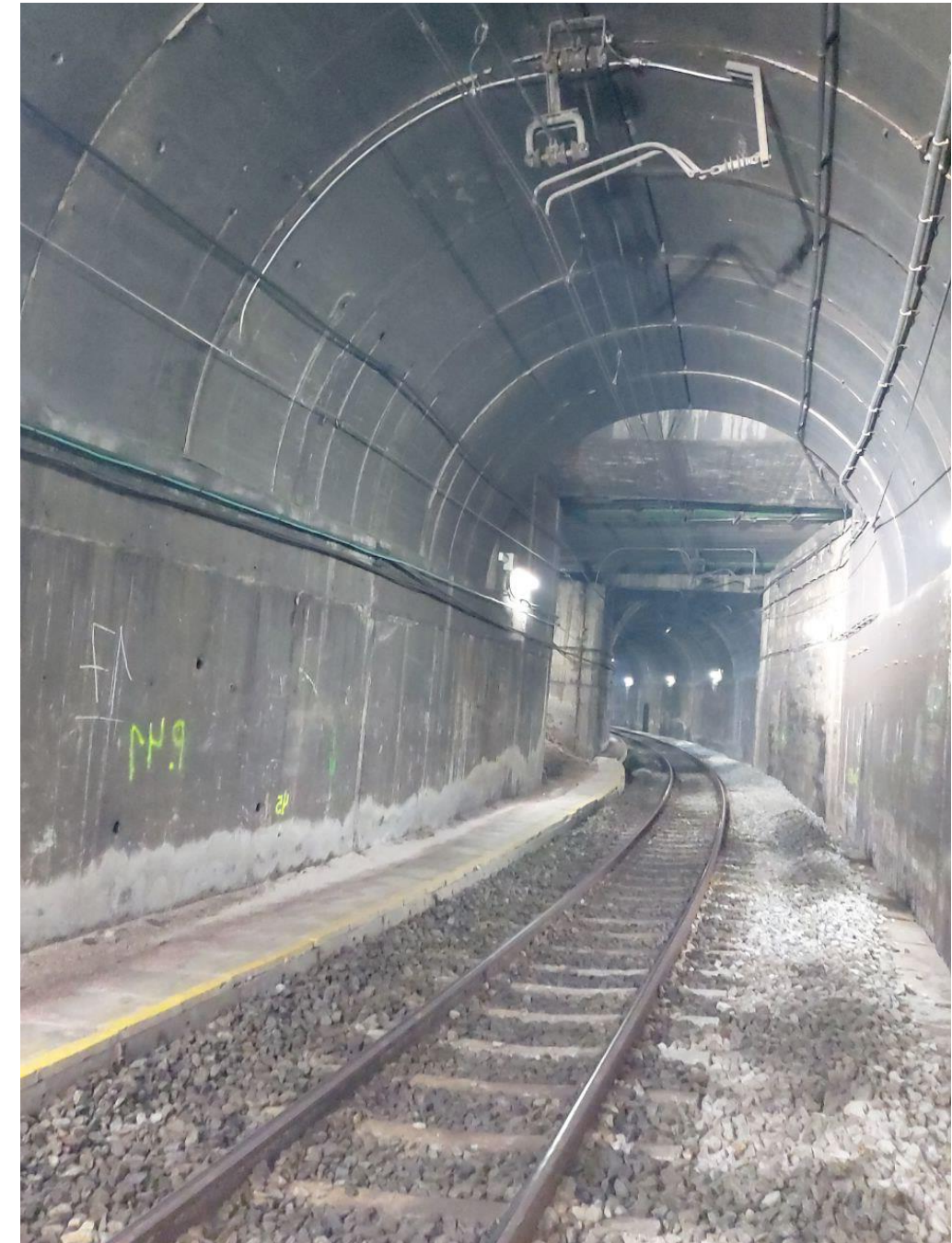
Fotografia 14 - Zona de túnel amb volta de pedra irregular i suport Ca 2-1 allargat i Ca4-1 de feeder. Connexions a terra dels suports atirantat i suspensió
