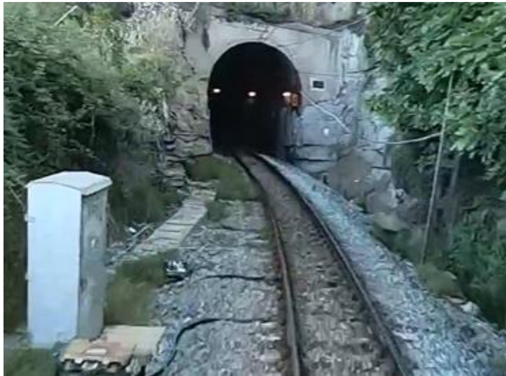
Fotografia 1 - Boca sud túnel de Viladordis (Santa Clara)
