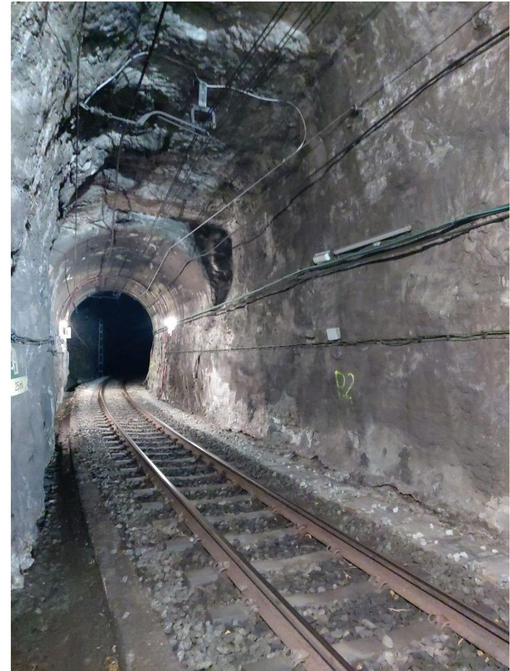
Fotografia 12 - Zona de túnel amb volta de pedra irregular, y suport Ca 2-2 allargat
