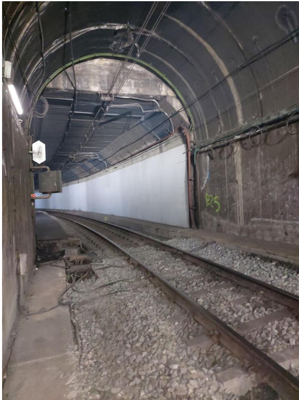
Fotografia 7 - Estació Manresa Viladordis, volta plana amb baix gàlib d'altura
