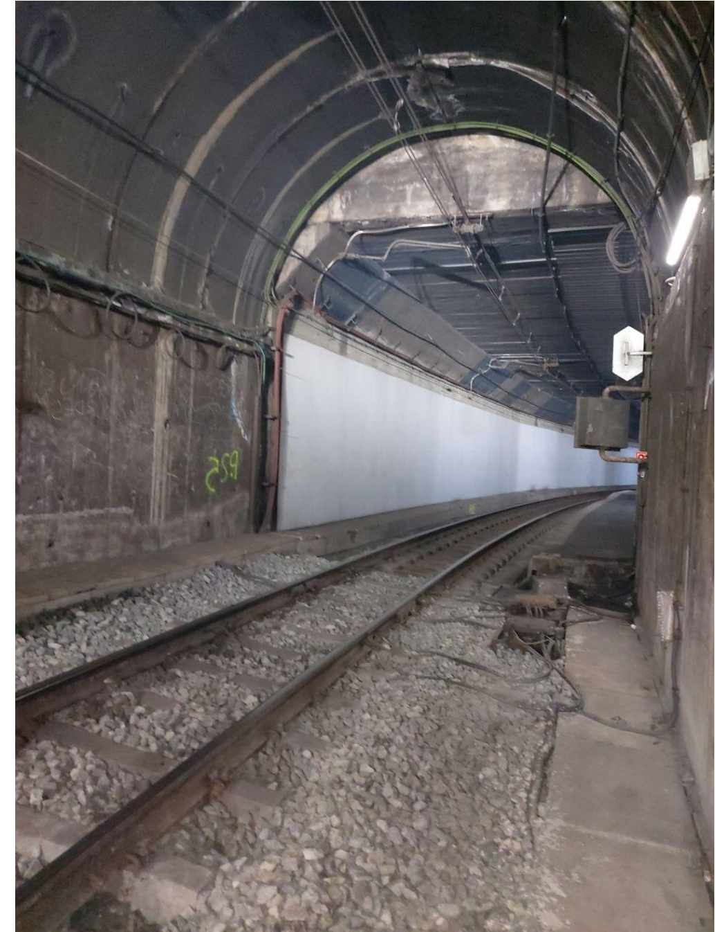
Fotografia 6 - Estació Manresa Viladordis costat Manresa Alta
