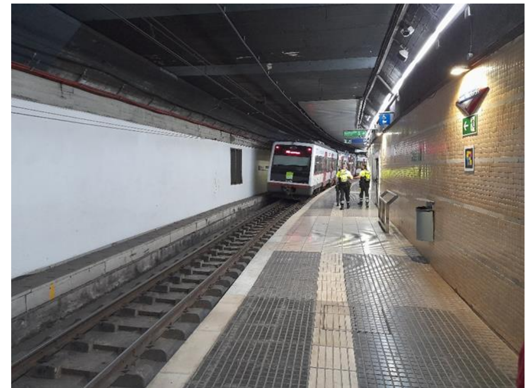
Fotografia 4 - Estació Manresa-Viladordis. Zona andana amb alçada de catenària amb gàlib reduït
