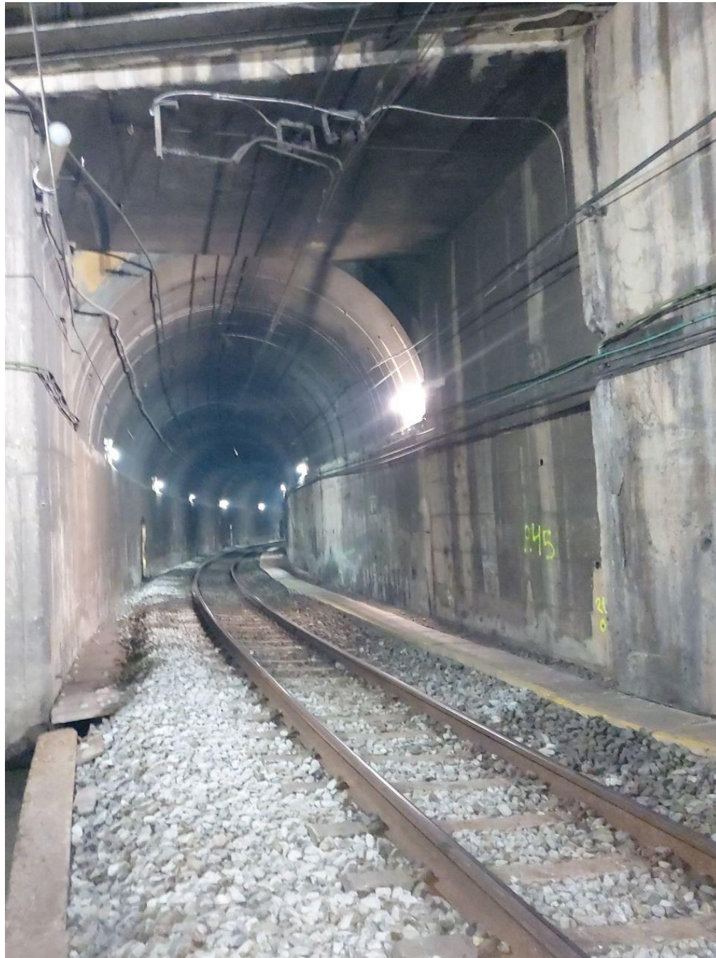
Fotografia 9 - Zona del túnel amb volta plana i volta circular
