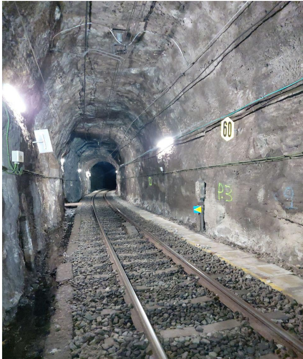
Fotografia 11 - Zona de túnel amb volta de pedra irregular i suport Ca 2-2 allargat
