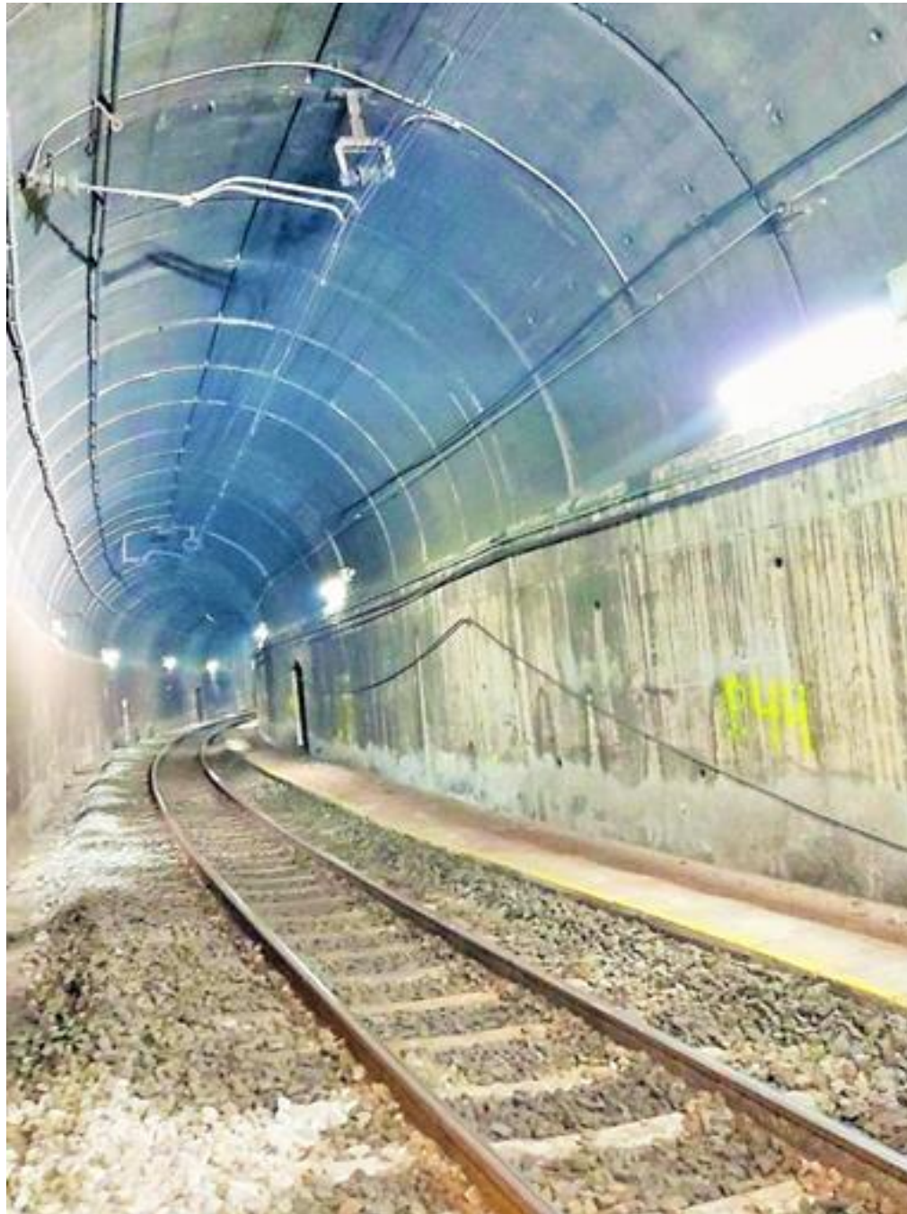
Fotografia 15 - Zona túnel en corba amb volta de formigó regular, atirantat Ca 28-T
