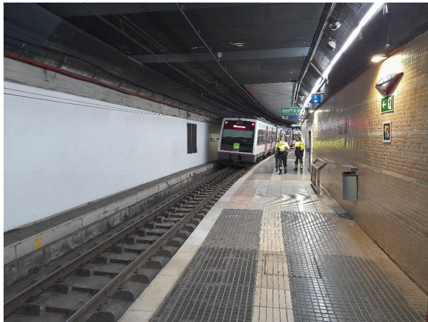
Imatge 1 – Estació Manresa Viladordis PK59+749
