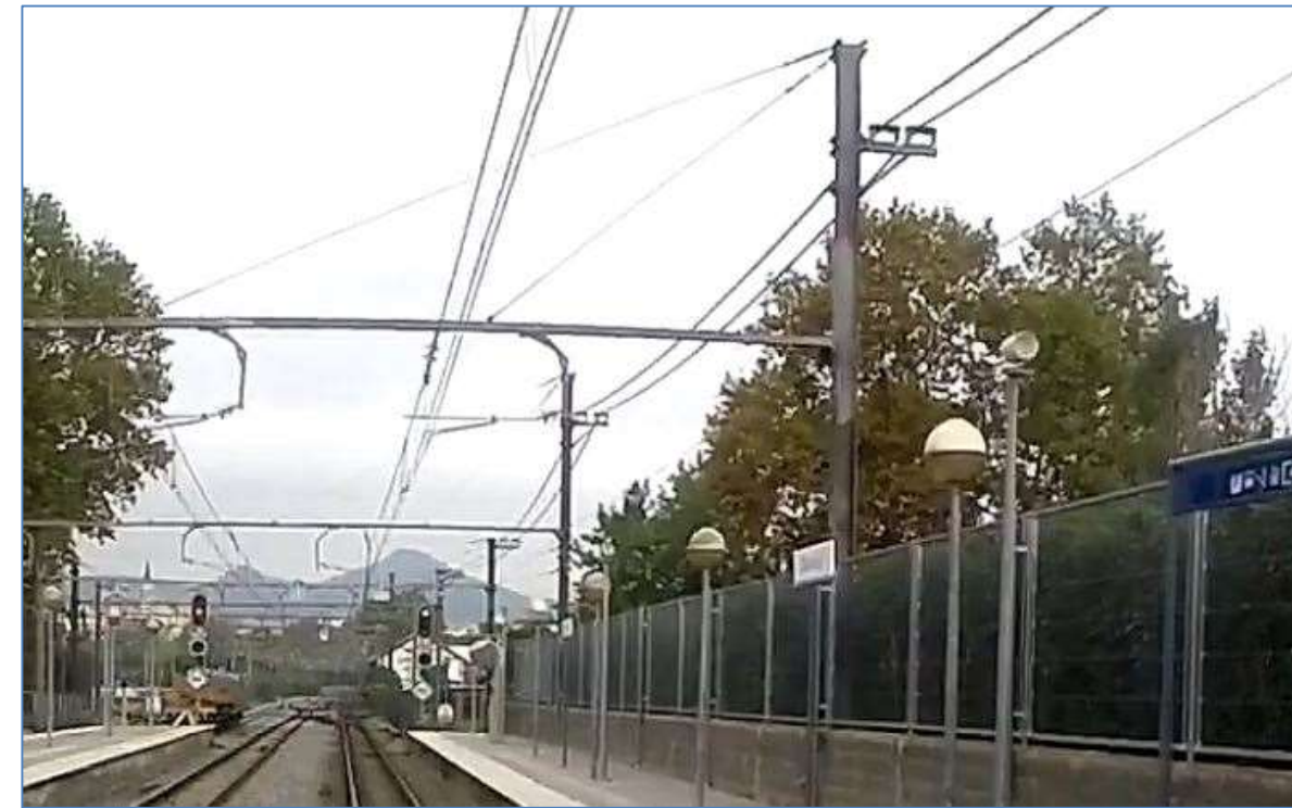
Fotografia 6 - Estació Sant Boi. Suspensions per 2 feeders a pal tipus gray amb W1a especial
