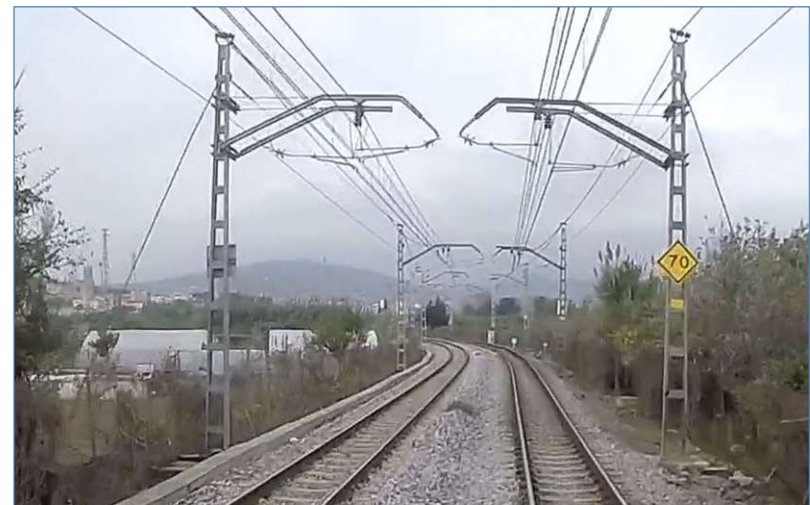
Fotografia 4 — Costat Sant Boi - Cornellà. Làmina d'aire de vies 1 i 2 .
