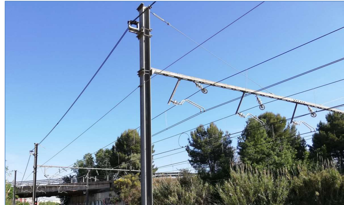
Fotografia 2 – Costat Sant Boi - Molí Nou. Suspensió de feeder a pal tipus Gray sobre W1a.
