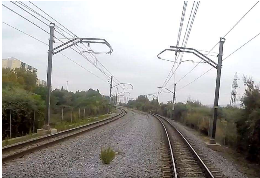
Imatge 2 – Suspensió de feeder a cap de pal tipus GRAY a eliminar
