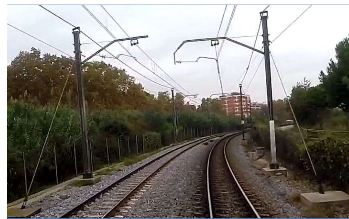
Fotografia 8 - Costat Sant Boi – Molí Nou. Suspensions de feeder a cap de pal tipus gray a substituir per suport sobre W1a.
