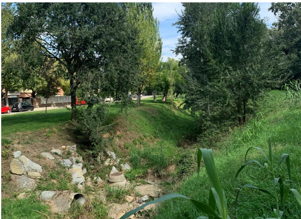
Figura 2. Estat actual de la riera de Can Cabassa al punt d'ubicació de la nova passarel·la.
