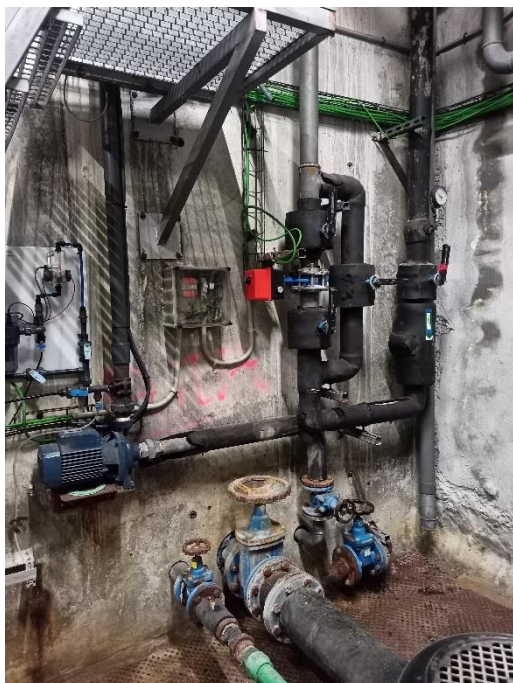
VISTA CONNEXIONS A DIPÒSIT AFS I CLORIFICADOR
