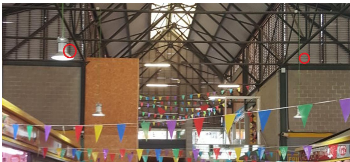
Punts de sortida conductes a terrasses exteriors
