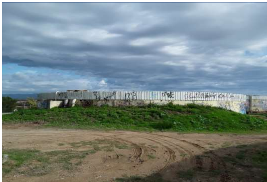
Figura 10. Vista general del Dipòsit de Pinetons 2
