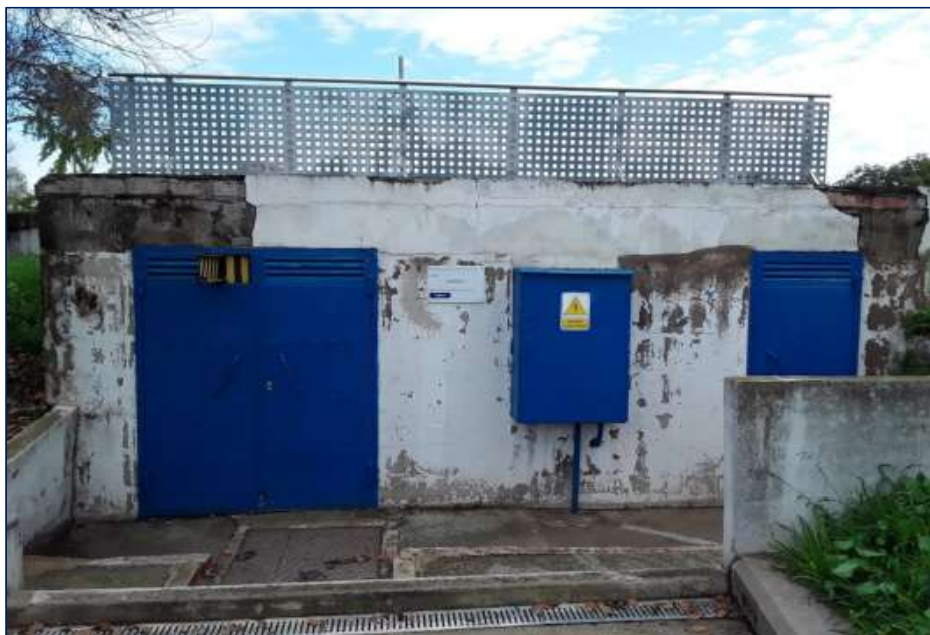
Figura 13. Vista de l'entrada a l'estació d'elevació del Cementiri
