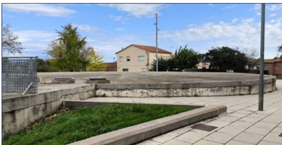
Figura 6. Vista general al Dipòsit del Cementiri
