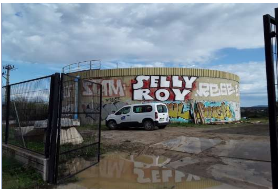
Figura 12. Vista general del Dipòsit del Mansar 2
