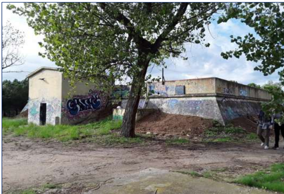
Figura 9. Vista general del Dipòsit de Pinetons 1
