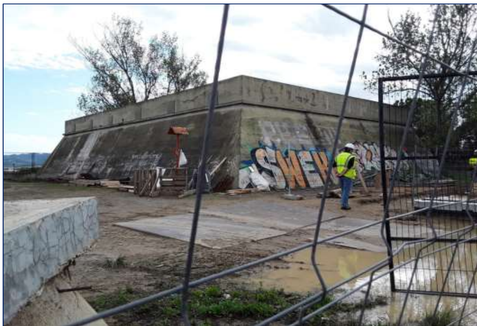
Figura 11. Vista general del Dipòsit del Mansar 1
