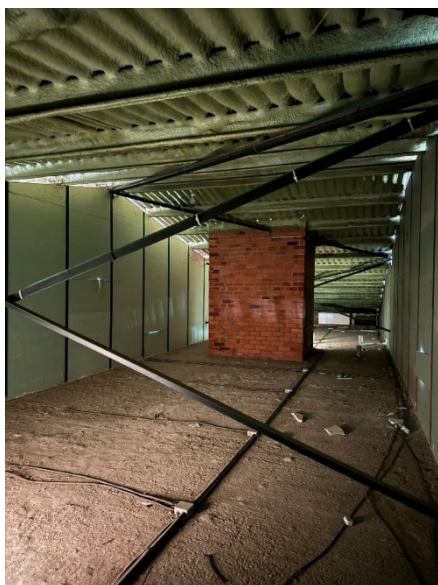
Espai sota coberta transitable
