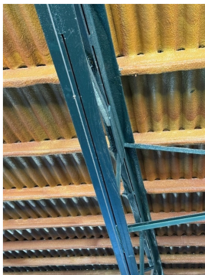
Encavallada i coberta
