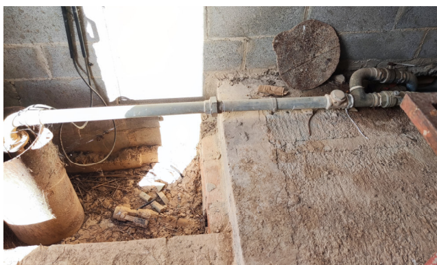
Fotografia 1 Estat actual de l'equipament de la captació
