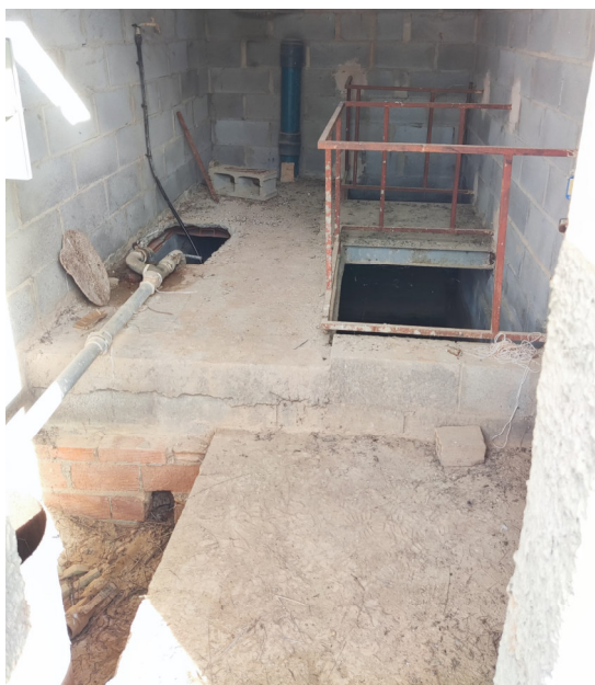
Fotografia 3 Estat actual del terra de la caseta
