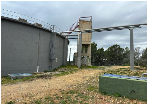
Foto 4.- Zona d'execució de la canonada del pou 1
