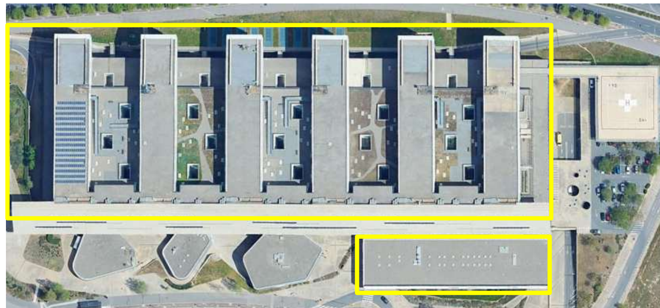
Imatge 2. Imatge aèria zona de treballs
