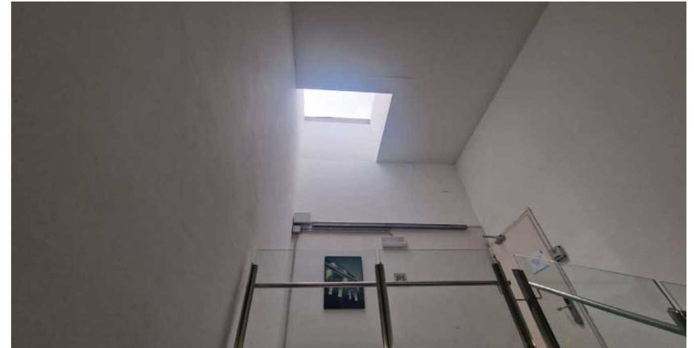
Imatge 3. Accés amb trapa on s'emplaça una escala per accedir a la coberta de Gerència
