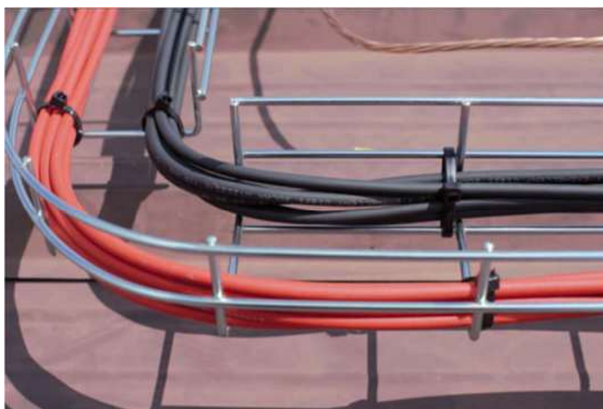
Imatge 85. Separació de cablejat per polaritat, previ a la col·locació de la tapa de la safata
