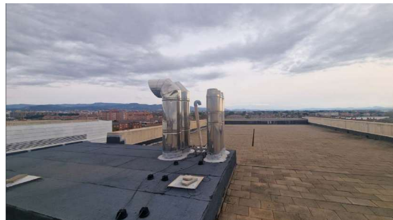
Imatge 103. Zona lliure de línia de vida per mur perimetral
