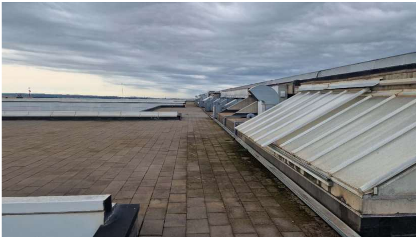
Imatge 2. Imatge coberta, vista Est-Oest
