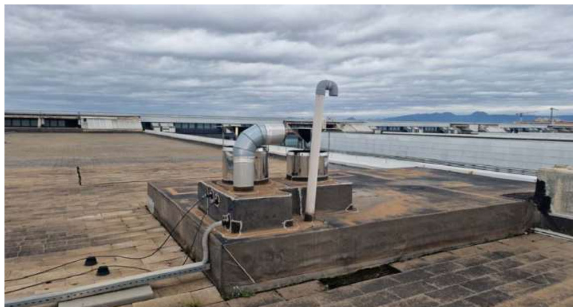
Imatge 62. zona baixant cablejat espina F, a tocar de les xemeneies existents
