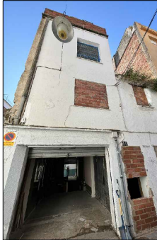
Façana carrer Migdia
