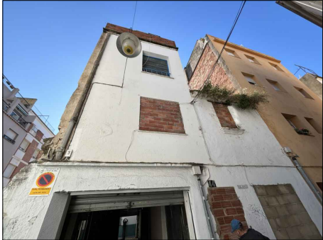
Façana carrer Migdia
