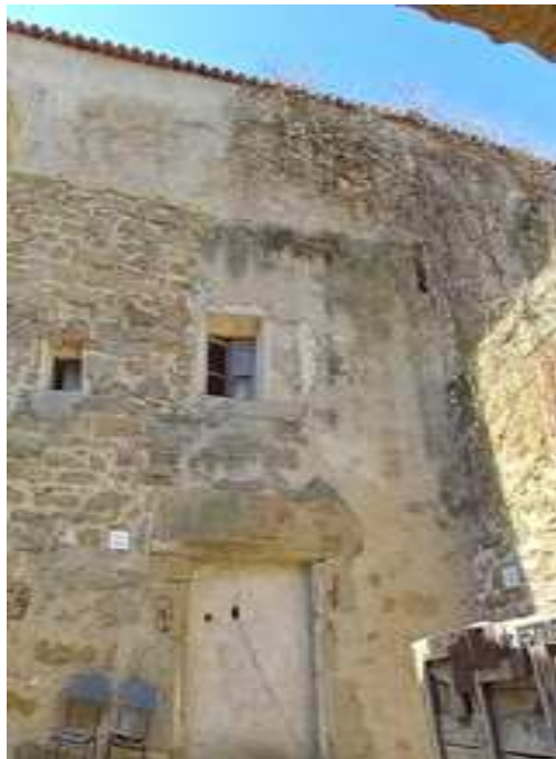
Façana posterior - carrer Lo Carreró
