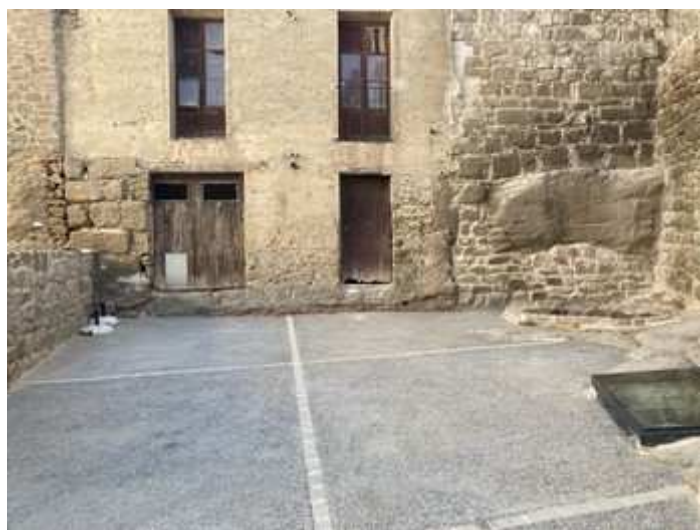
Façana principal - carrer Domènec Cardenal, 6
