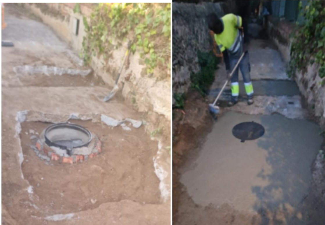
Fotografies 5 i 6: Reblert i formigonat de la zona oberta.
