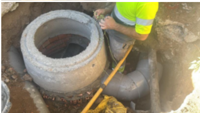
Fotografia 3 i 4: Vista dels treballs de connexió realitzats (pou de registre)
