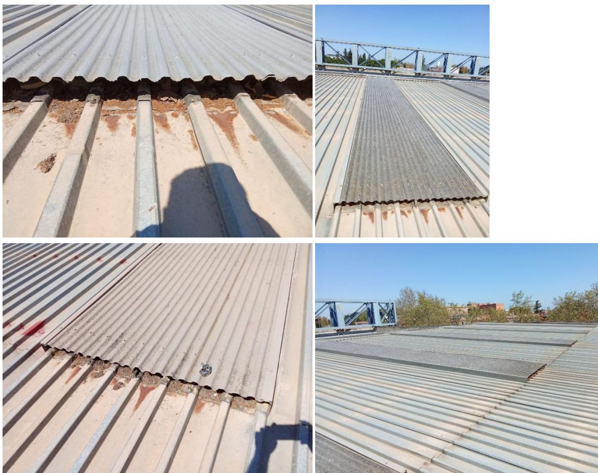
Imatges coberta lleugera
