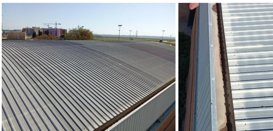
Imatges coberta lleugera
