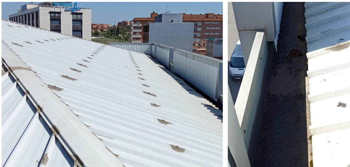
Imatges coberta lleugera
