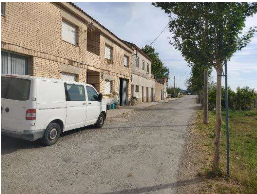
Avinguda de la Llum núm. 39-43 (vista nord a sud)
