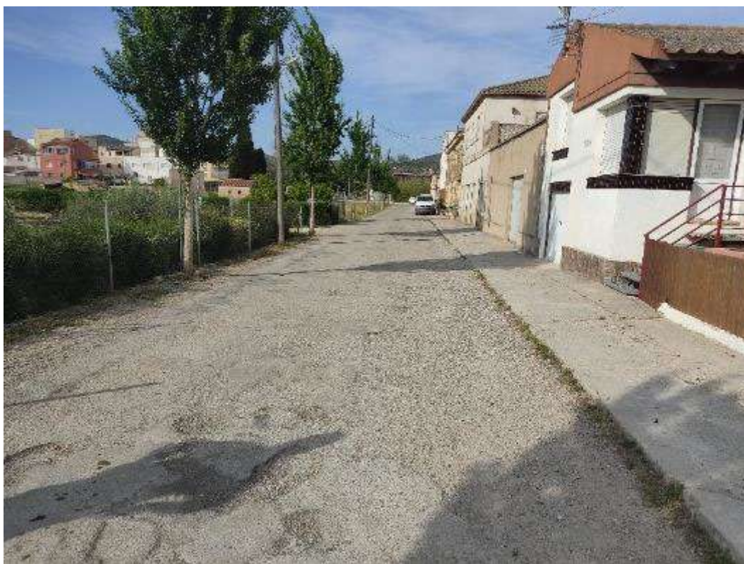
Avinguda de la Llum núm. 55-57 (vista sud a nord)
