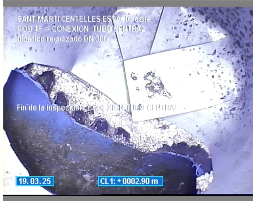
Foto: 7_2A, Medio N°: 190325_1, 00:00:26 2,9m, Fin de la inspección / CONEXION TUBO CENTRAL
