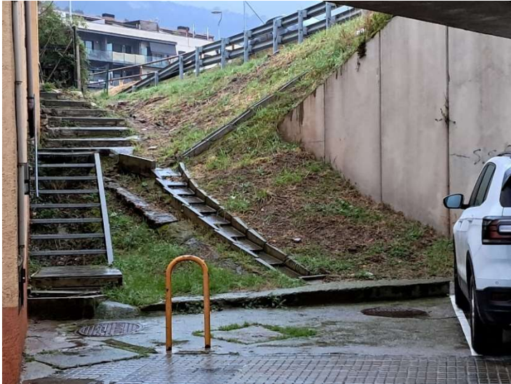
Imatge de la zona de les escales des de la part del carrer Major
