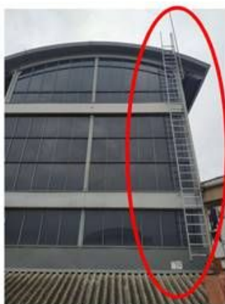
Fig.11 . Detall de l'escala d'accés a la lluernia principal
