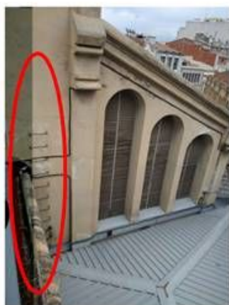
Fig.6 . Detall de l'escala de pates d'accés a la coberta inferior sud de la passera tècnica
