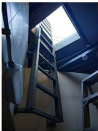
Fig.2 . Detall de l'escala d'accés a coberta des de l'interior del Mercat
