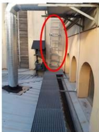
Fig.4 . Detall de l'escala d'accés a la passera tècnica. Part inferior.
