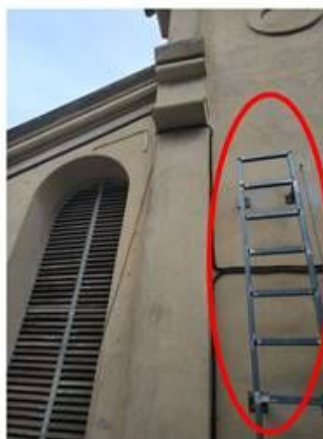
Fig.5 . Detall de l'escala d'accés a la passera tècnica. Part inferior.
