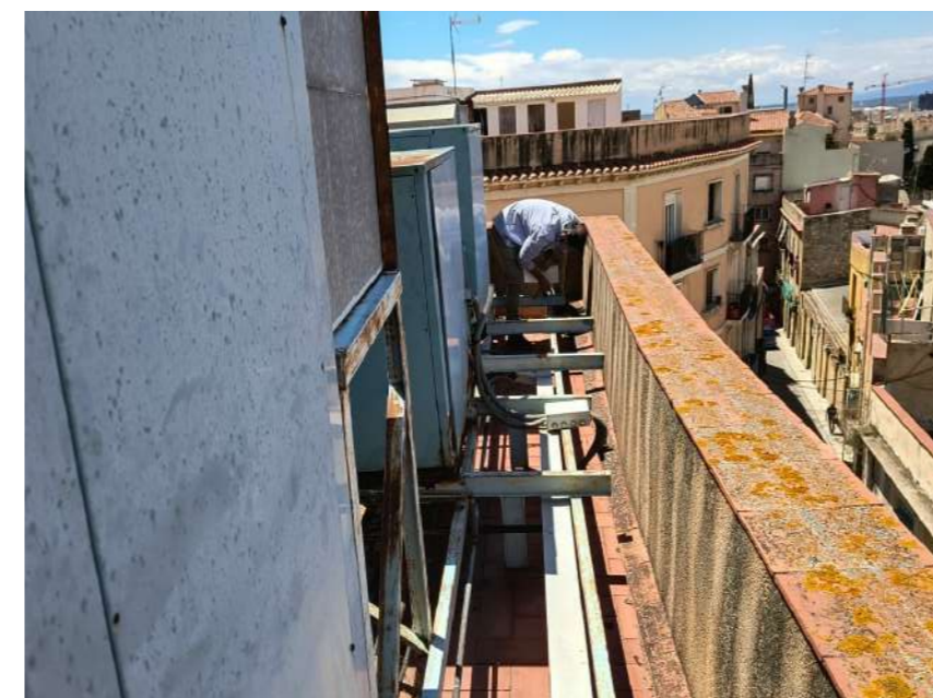
Vista de equipos existentes a retirar y peto de cubierta
