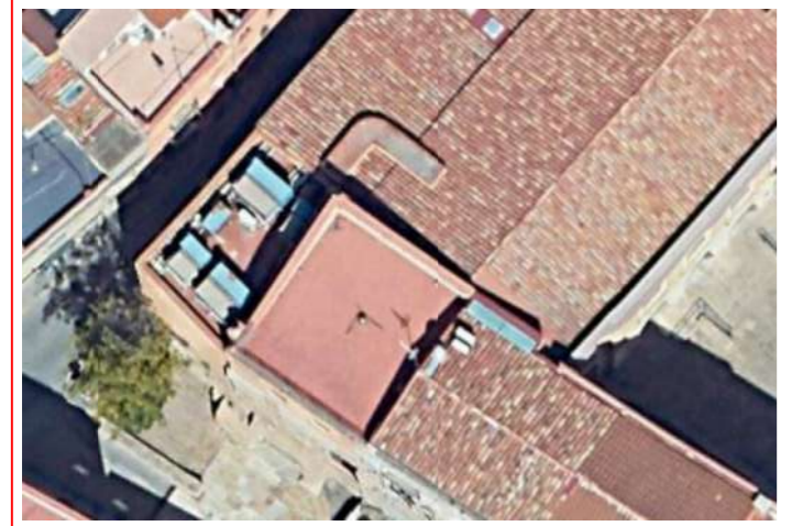
Tramo de conducto que discurre por cubierta a adecuar con aprovechamiento para estado proyectado
