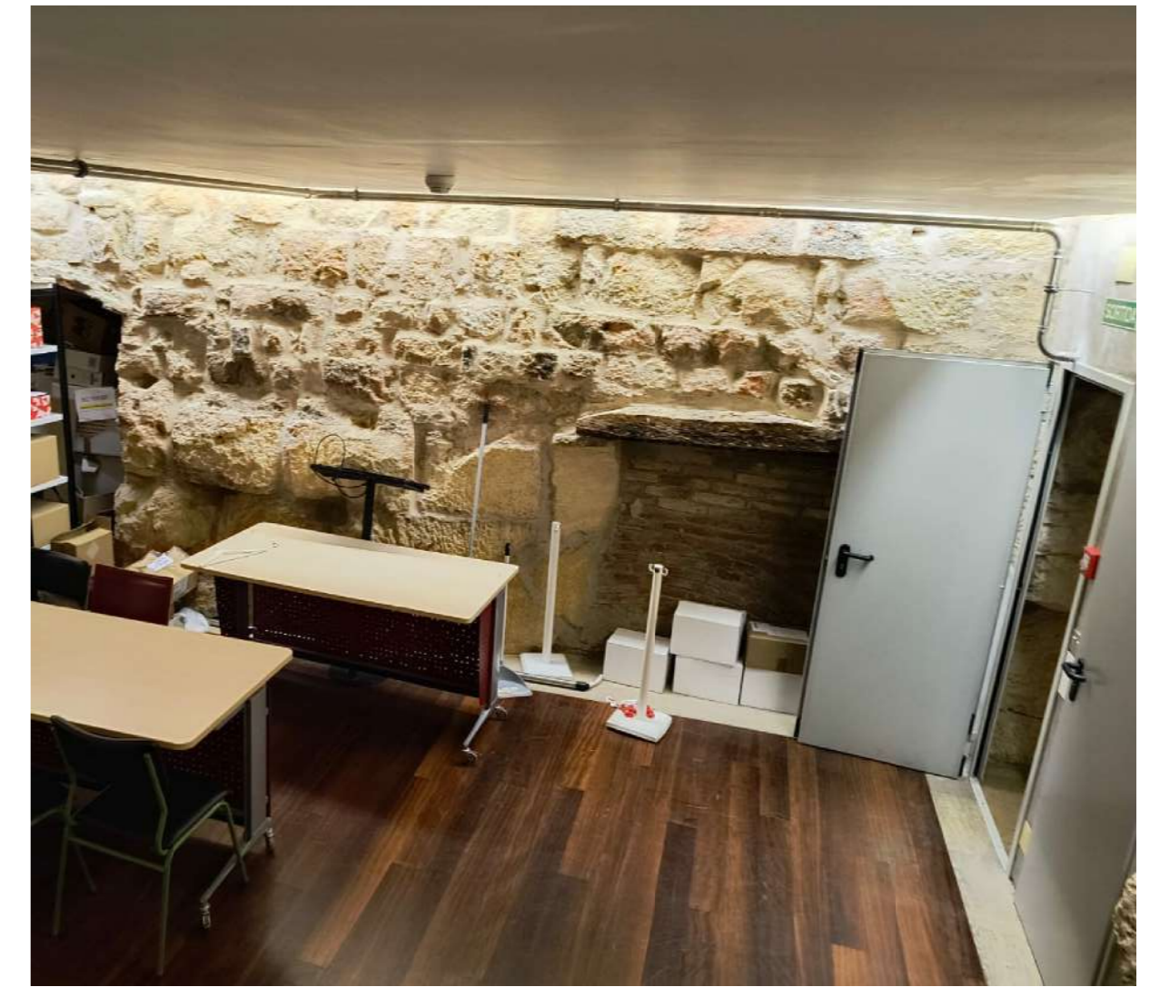
Vista muro protegido en sala archivo planta primera
