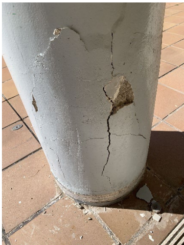
Estructura alterada i amb corrosió
