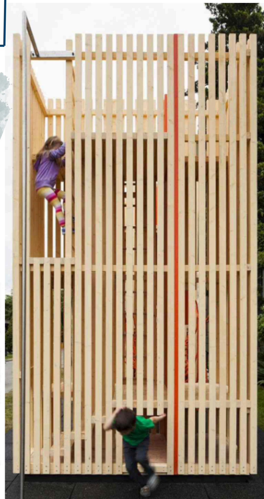
07 CASETA DE FUSTA
